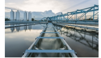
Traitement de l'eau
