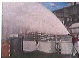
Canons à mousse poste de dépotage
