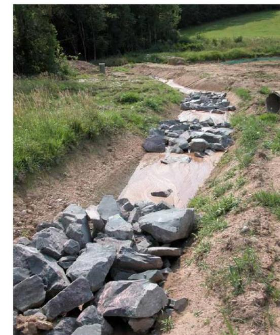
**Fossés de collecte des eaux de chantier, avec dispositif de réduction de la vitesse (blocs en cascade) pour les fortes pentes**
