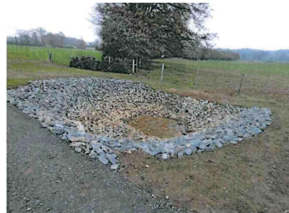
**Exemple de fosse de diffusion en enrochements non bétonnés phase travaux qui sert de piégeage des sédiments**
