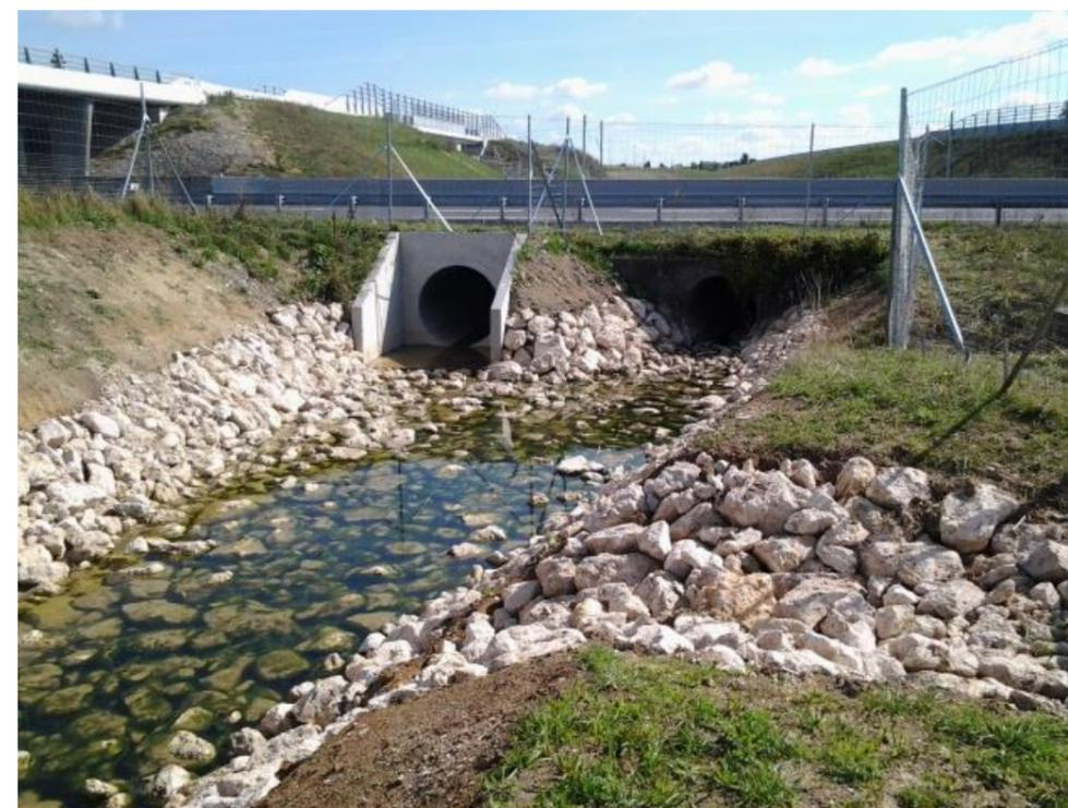
Exemple de rétablissement de cours d'eau et exutoire d'un rejet latéral à droite
