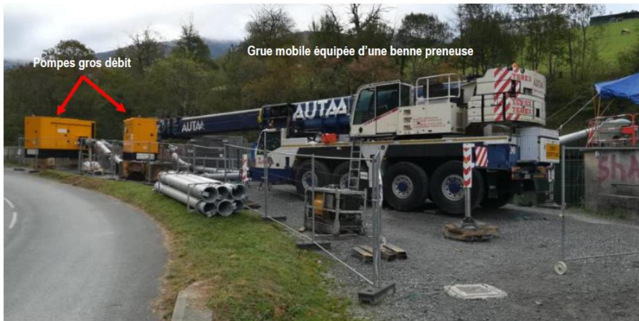
Figure 4 : Équipements sur la plateforme de chantier – octobre 2018
