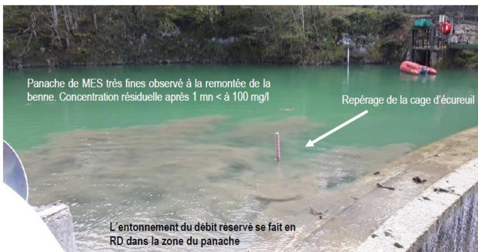
Figure 15 : Tests réalisés en 2018 : retenue en amont immédiat du parement dans la zone de curage
