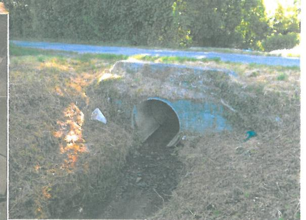
Photo n°3 : vue du ruisseau busé. Les travaux incluent un allongement de la buse pour permettre l'écoulement du ruisseau.
