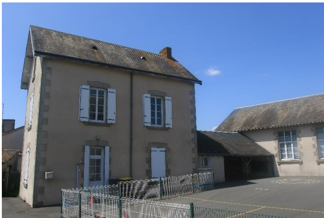
Photo 1&2 : façades Est avant les travaux d'aménagement
