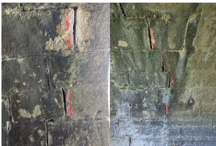
Figure 8 : Marquage des cavités à conserver sous la voûte 2.
