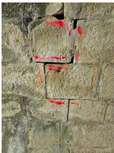
Figure 7 : Marquage des cavités à conserver sous la voûte 1.
