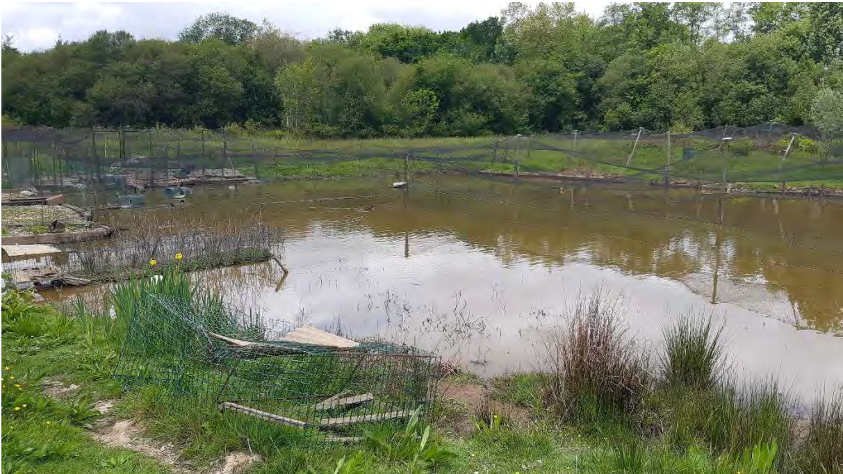
Tonne de chasse secondaire au nord du site © Apexe 2022.
