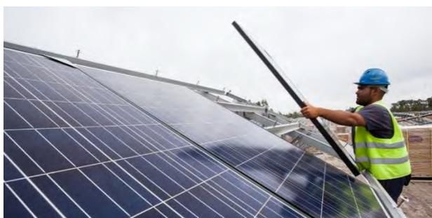
Les modules sont positionnés sur les supports en respectant un espacement afin de **laisser l'eau s'écouler dans ces interstices**.
