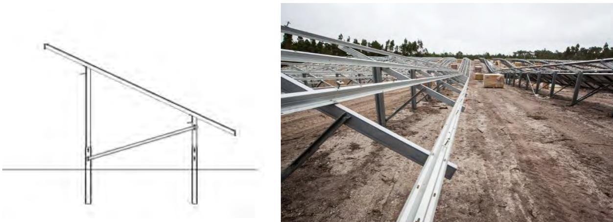
*Schéma de principe et illustration d'une table bipieux, battus dans le sol (source : NEOEN)*
