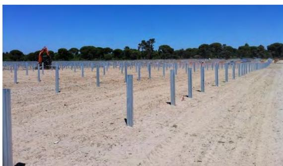
Cette phase est soumise aux résultats des études géotechniques. La profondeur maximale des pieux est comprise entre 1,50 m et 2,50 m.
