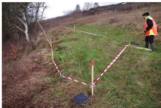
Illustration 8 : Exemple d'un balisage (piquets + rubalise) préalable aux travaux.
