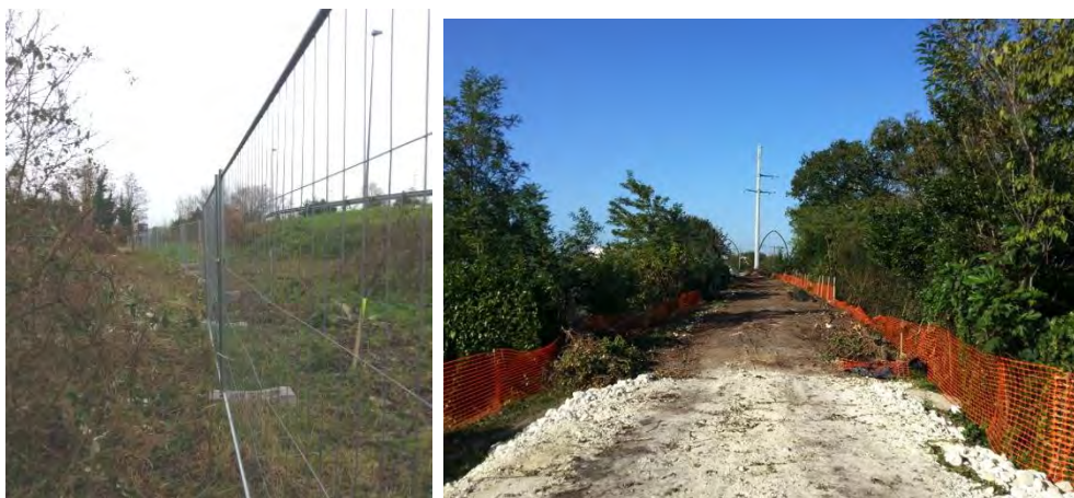
Exemple de clôtures de chantier de type Héras ou avertisseur (source : Apave)
