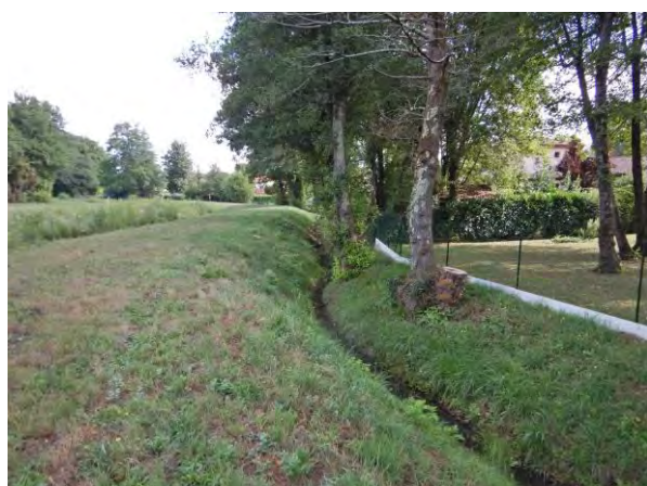
Fossé et aulnaie
