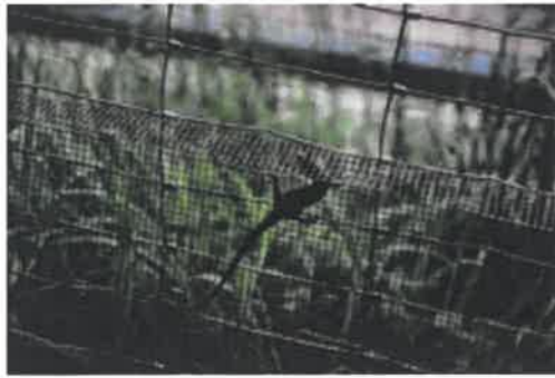
Photo 6 : Triton escaladant un treillis de 6,5 x 6,5 mm plaqué sur un treillis noué ; l'ascension est stoppée par le rabat (partie supérieure recourbée). Cette disposition constructive est efficace pour les amphibiens et les reptiles. Elle s'avère délicate à mettre en œuvre et à pérenniser (Source : H. Bekker)
