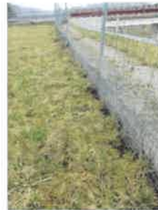
Photo 7 : Combinaison de trois clôtures posées au sol ( LGV Est) : • une clôture à maille progressive de type 3 • une clôture petite faune • une clôture 50 x 50 mm pliée et brochée au sol empêchant les animaux fouisseurs de soulever ce dispositif. (Source : Cerema Est)
