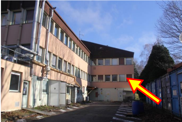
Photo : Face Ouest-2 du bâtiment
