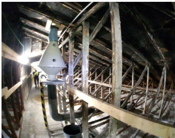
Photo : Vue d'ensemble du comble du bâtiment
