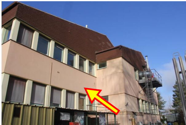
Photo : Face Est-2 du bâtiment
