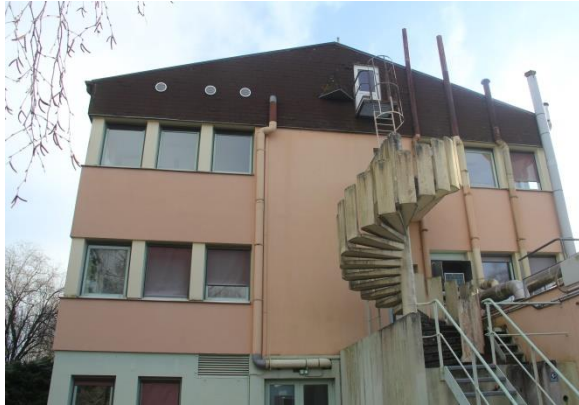
Photo : Face Ouest-1 du bâtiment
