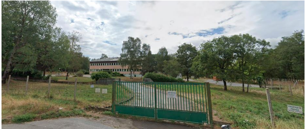
Figure : Photographie du bâtiment de la SAN prise depuis la route D711 de Chateauponsac
