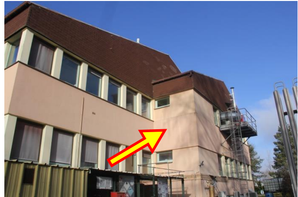
Photo : Face Sud-1 du bâtiment
