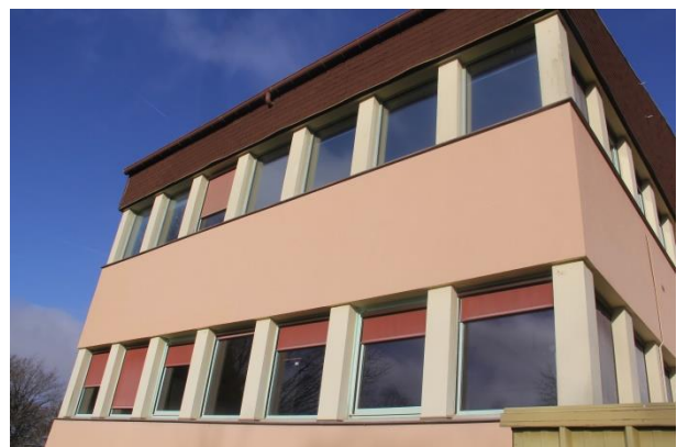
Photo : Face Sud-2 du bâtiment
