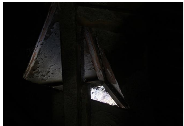
Photo : Grille d'aération du comble, accès possible pour les chiroptères
