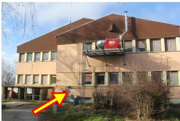
Photo : Face Est-1 du bâtiment
