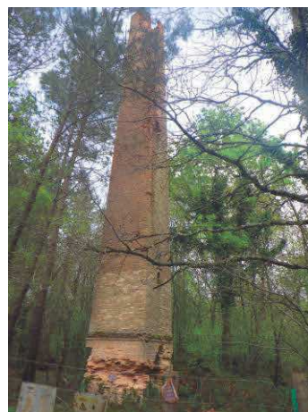
Tour de cheminée en brique
