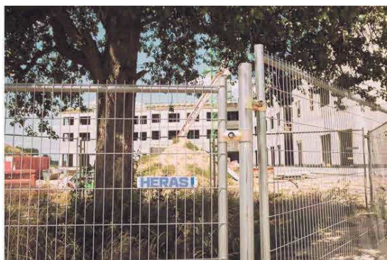
Figure 19 : Barrière HERAS protégeant un arbre en phase travaux (source : Poncelet)
