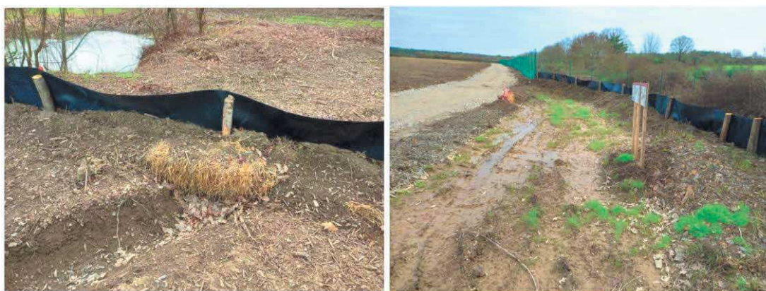
Figure 25 : Dispositifs type barrière petite faune (source : URBA 259)
