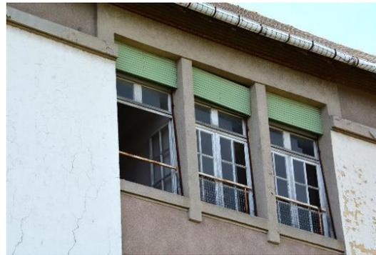
*Les coffres des volets roulants sont parfois en mauvais état et présentent des failles*
