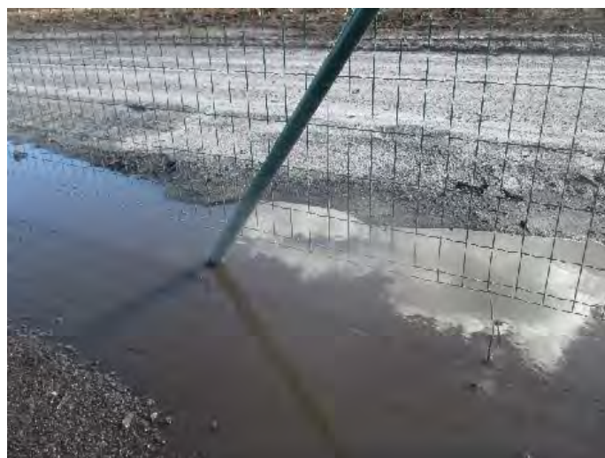
Figure 50 : Interstice préservé entre le sol et le bas de la clôture - Source ETEN
