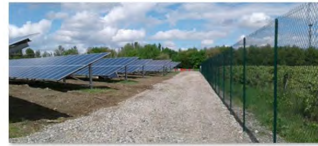
Noé (31) – 5MWc Réhabilitation d’un site dégradé (désamiantage du sol)
