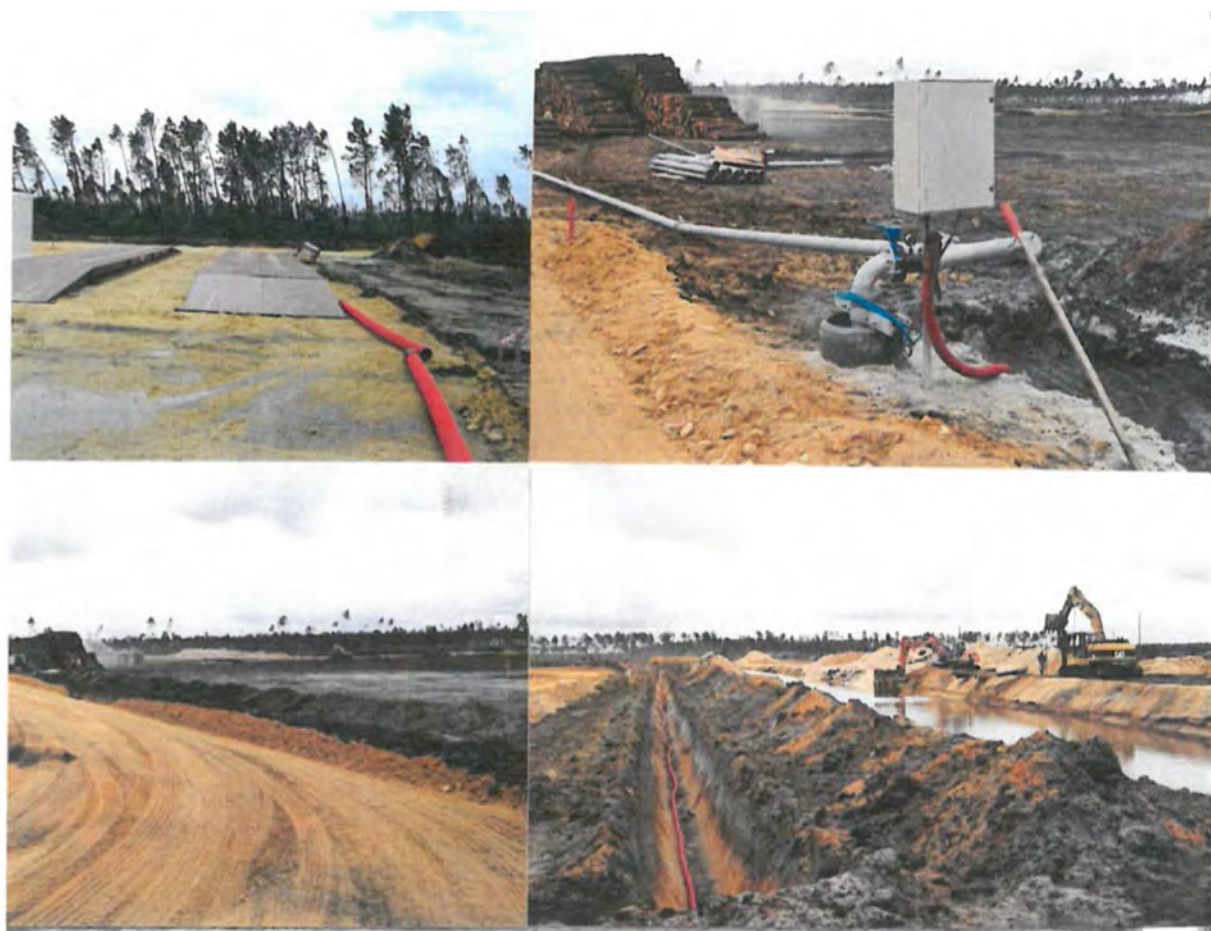
Travaux d'aménagement du site de la plateforme, pose des drains et des pompes d'aspersion sur le site en 2009.
