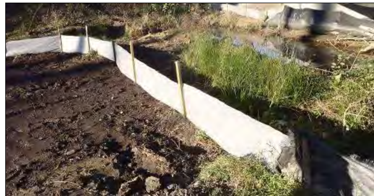
Figure 48 : Implantation de barrières amphibiens en géotextile permettant d’éviter les déplacements des individus du milieu aquatique vers le chantier © ETEN Environnement
