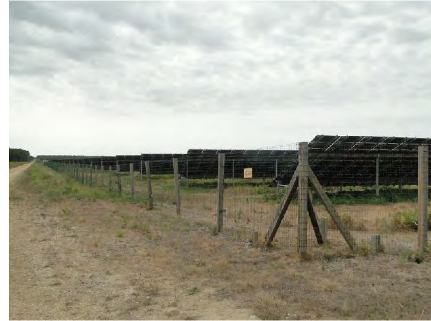
Figure 15 : Clôture, avec poteaux en pin des Landes - Centrale du Gabardan
