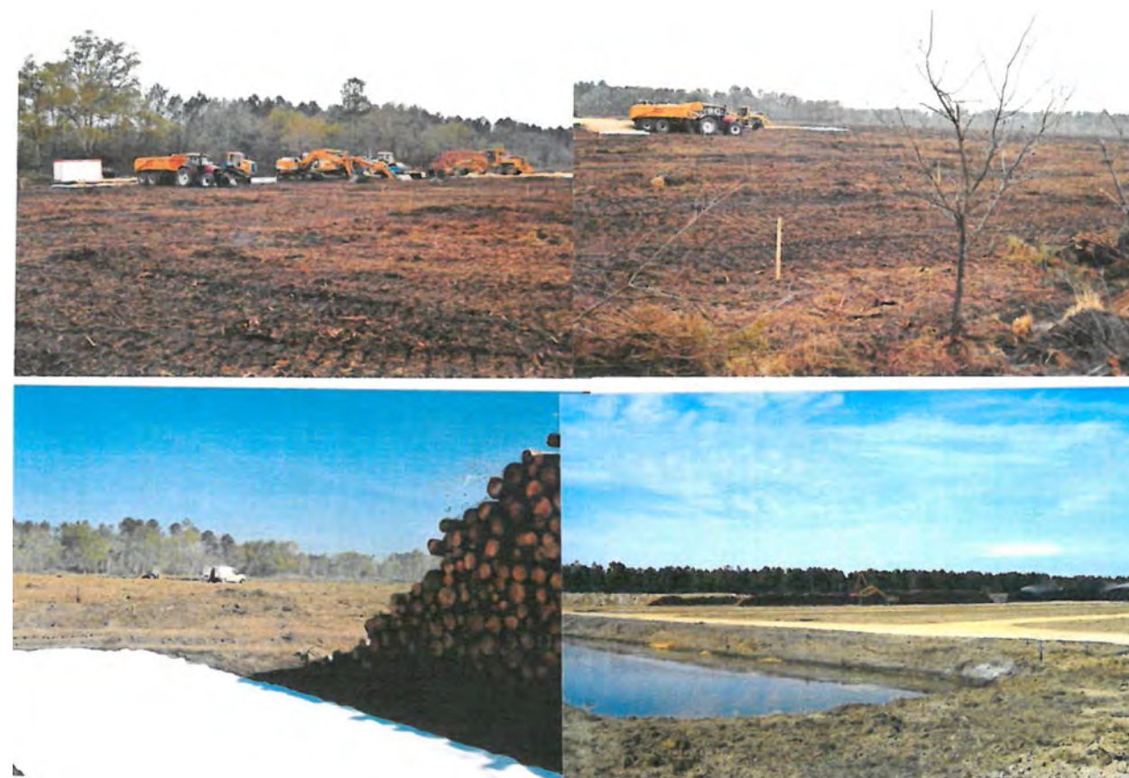
Terrassement et préparation des infrastructures, pose de géotextile et préparation des pistes forestières, creusement des bassins de rétention d’eau et pose des drains d’assainissement sous les alvéoles de stockage de bois.
