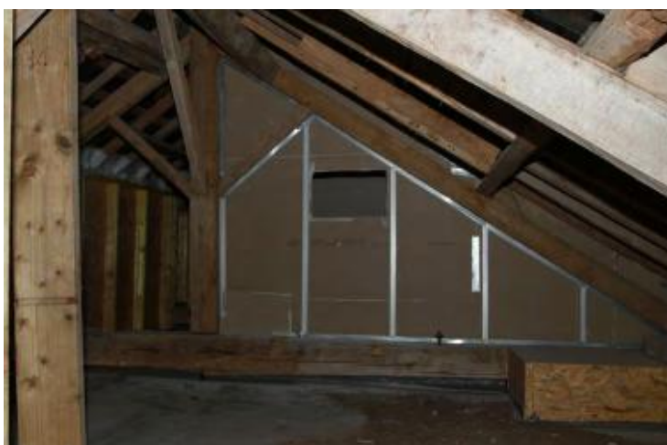
Figure 42 : Cas d'un sas créé avec du carton
