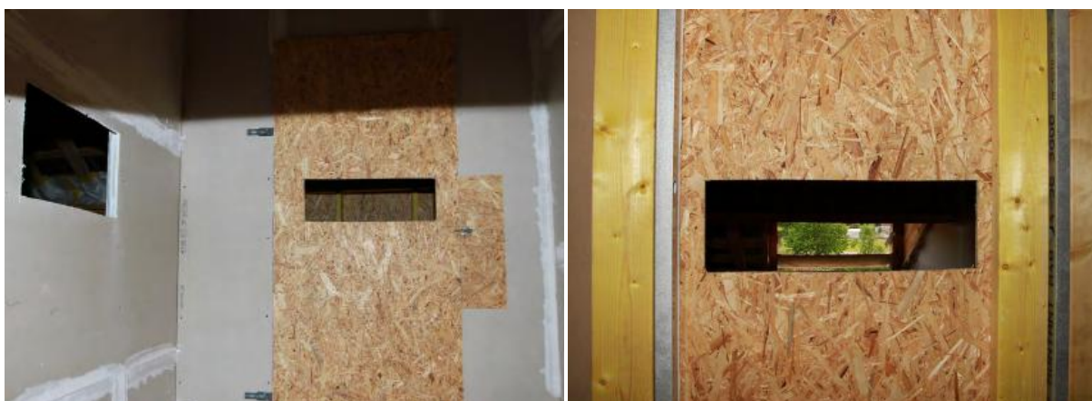
Figure 41 : Porte d'un sas vue depuis la chiroptière à gauche et alignement de l'ouverture du sas avec la chiroptière à droite
