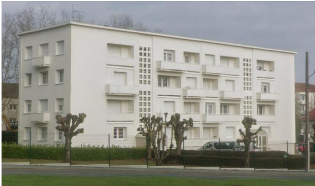
Figure 5 : Vue du bâtiment les Tilleuils
