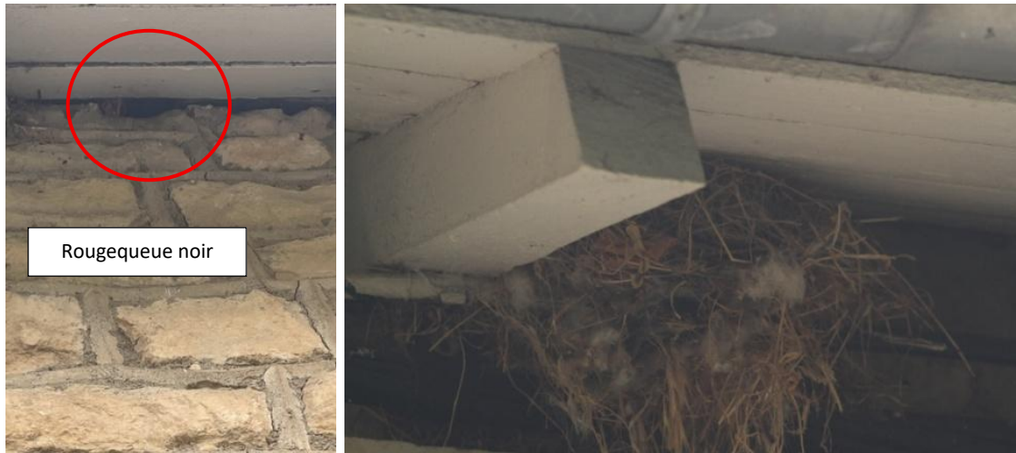
Figure 20 : Potentiels nids de Rougequeue noir au niveau du bâtiment 1
