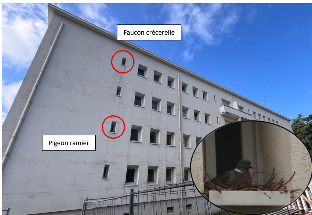
Figure 18 : Nids de Faucon crécerelle et de Pigeon ramier sur la façade du bâtiment 7
