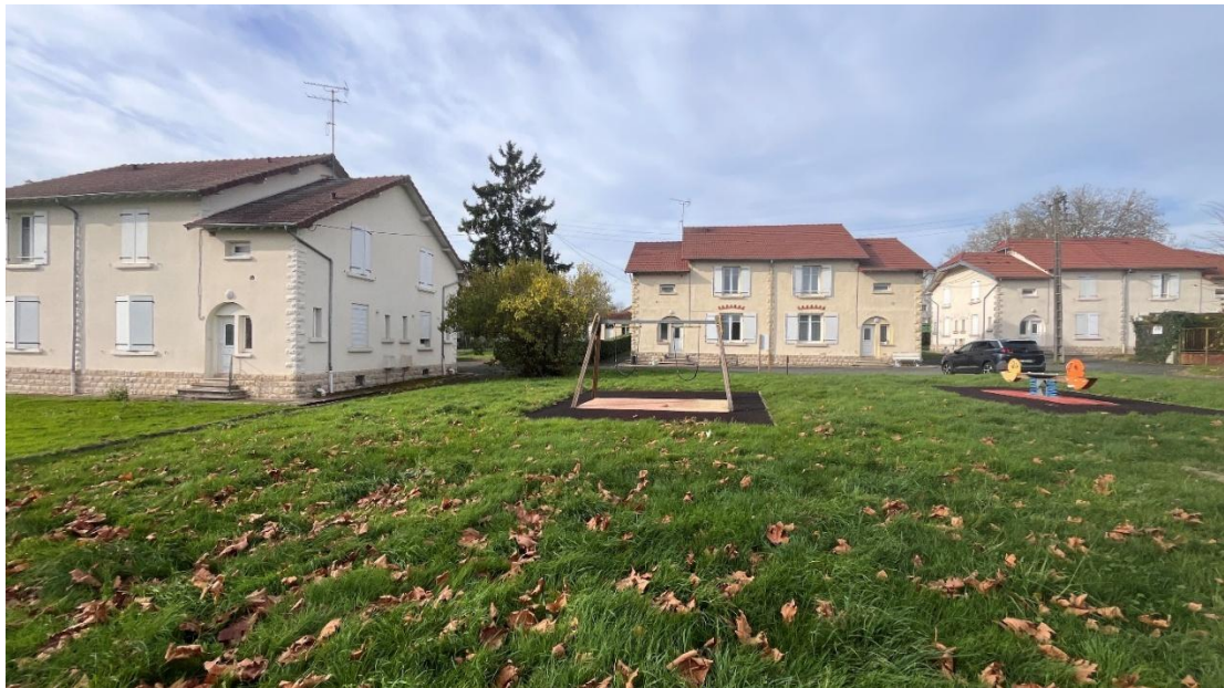
Figure 3 : Vue d'une partie du site
