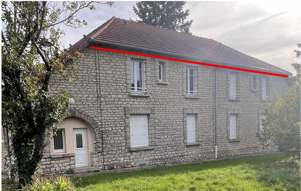
Figure 52 : Emplacements possibles des 7 nichoirs en façade est du bâti 2 (trait rouge)
