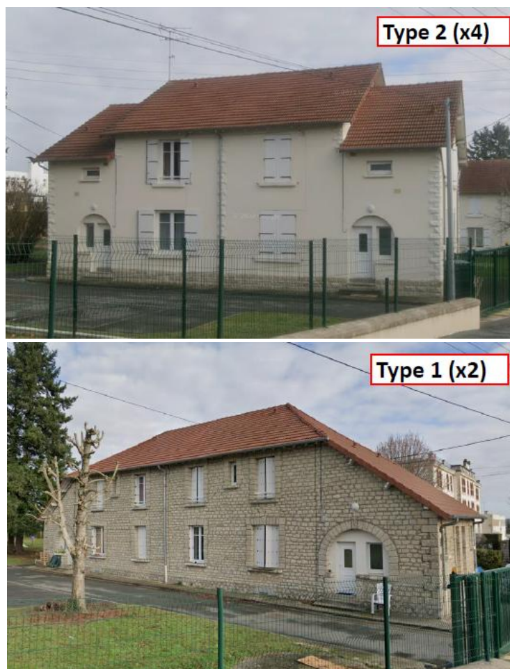
Figure 4 : Vue des 2 types de logements existants des Pavillons coiffe
