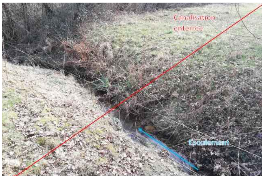
Figure 14 : Traversée semi-souterraine d'un affluent de la Baïse (Point 1-15) (Source : ARTELIA)
