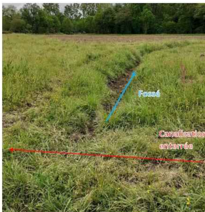
Figure 5 : Traversée d'un fossé en souterrain par la canalisation (Point 1-3) (Source : ARTELIA)
