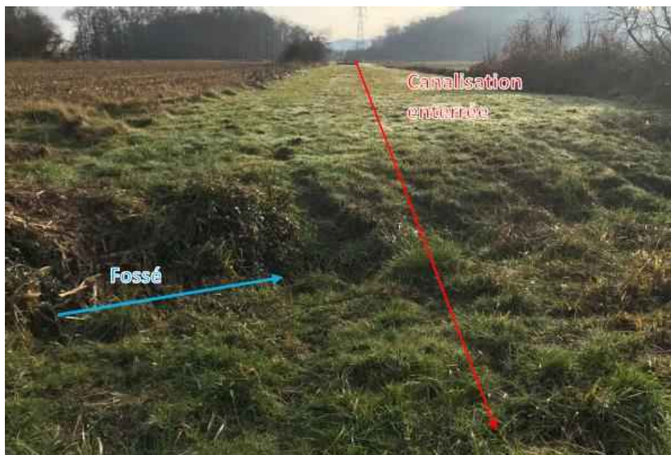
Figure 7 : Traversée d'un fossé en souterrain par la canalisation (Point 1-6) (Source : ARTELIA)
