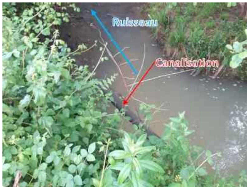
Figure 18 : Canalisation visible dans un méandre de la Baysère (Point 2-5) (Source : ARTELIA)
