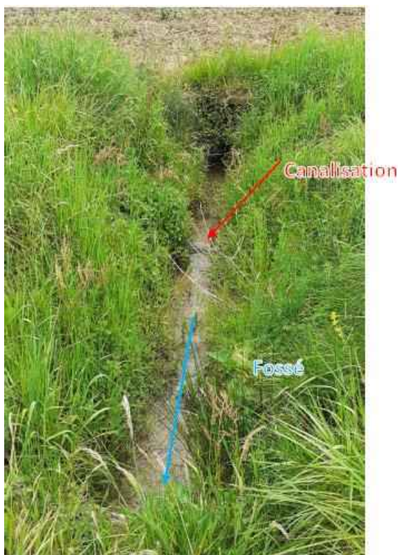
Figure 8 : Traversée semi-souterraine par la canalisation d'un fossé (Point 1-7) (Source : ARTELIA)
