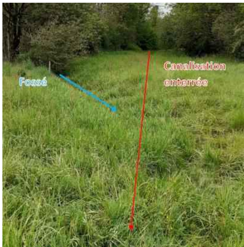
Figure 6 : Traversée d'un fossé en souterrain par la canalisation (Point 1-4) (Source : ARTELIA)
