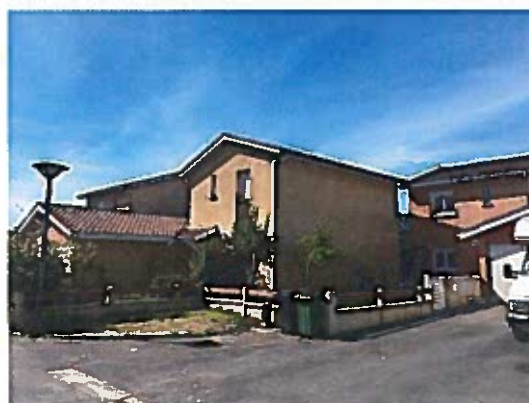
Figure 7: type d'habitation concernée avant travaux
