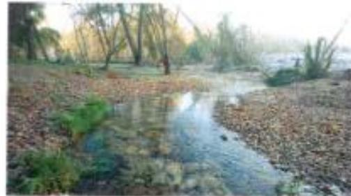
Recharge en granulat avec réduction de section par aménagement de banquettes minérales - Source de Ringère (Auxance)
