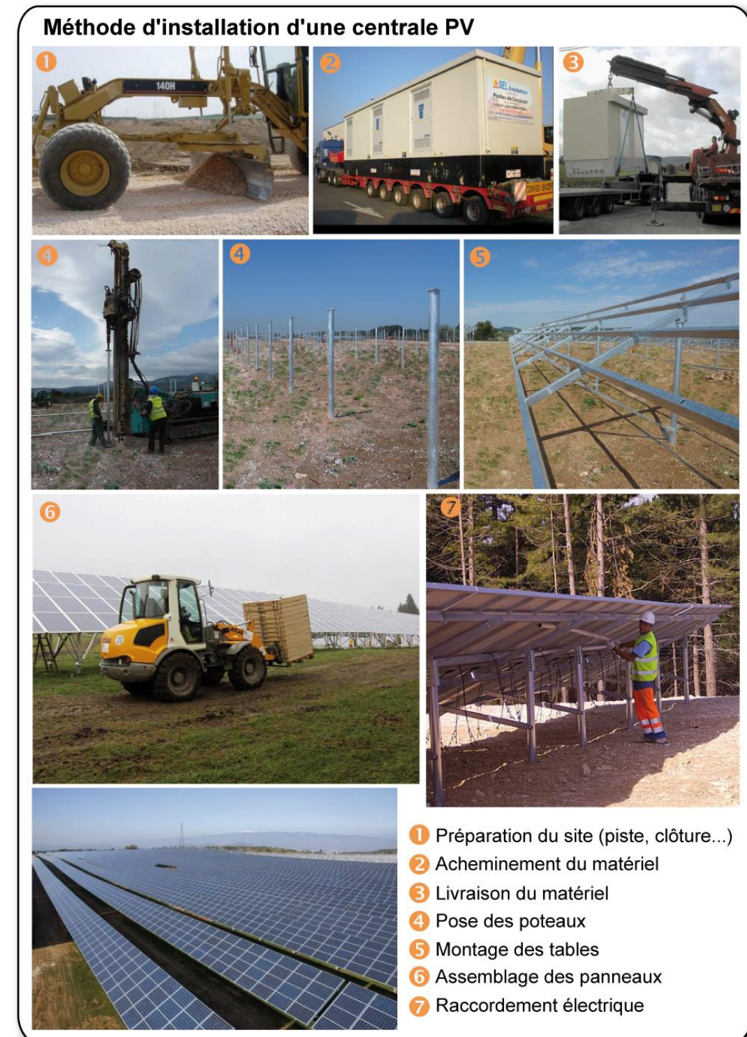
Photographie 1 : Construction d'une centrale photovoltaïque
