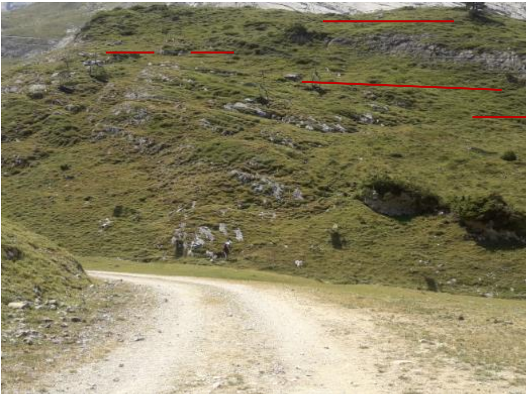
Figure 8 Installation des claies sur le secteur Bareille (source : Bruzy A., RTM, 2022)
