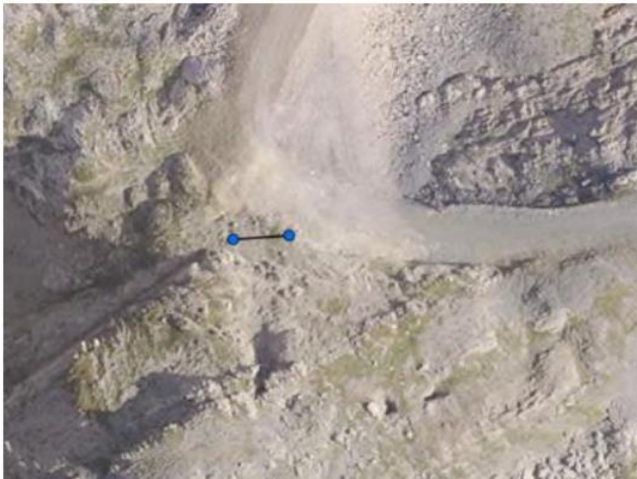
Figure 1 Localisation du linéaire d'implantation des claies à neige sur la falaise de la zone « Traversée Pene Blanque » (source : CD64 et ONF, 26/01/2022)
