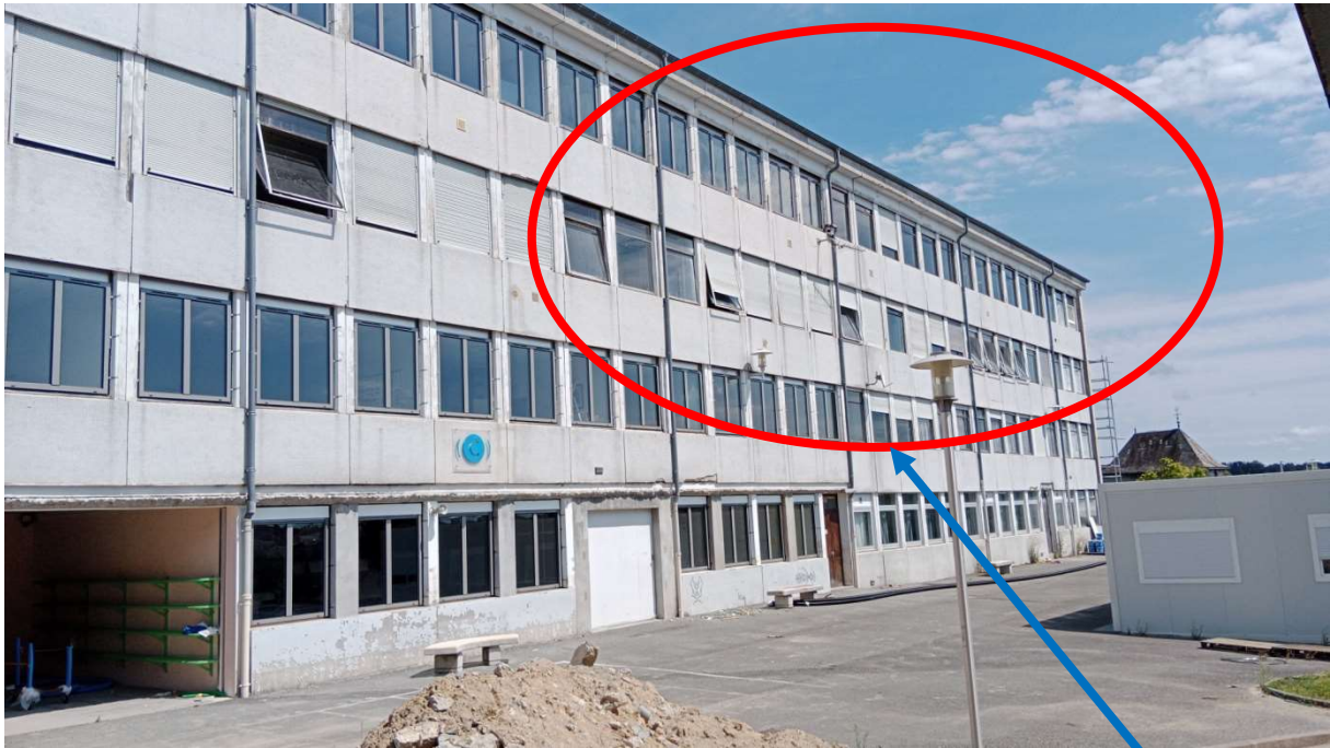
Façade Sud Existante après arrêt travaux Suite détection de nids de martinets
