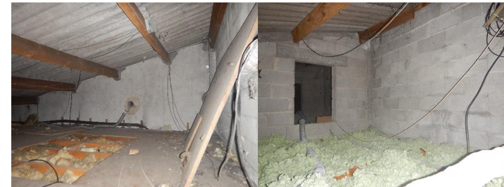
Figure 25 : Combles bien sombres des anciens bureaux "Laigné" (réf C).
