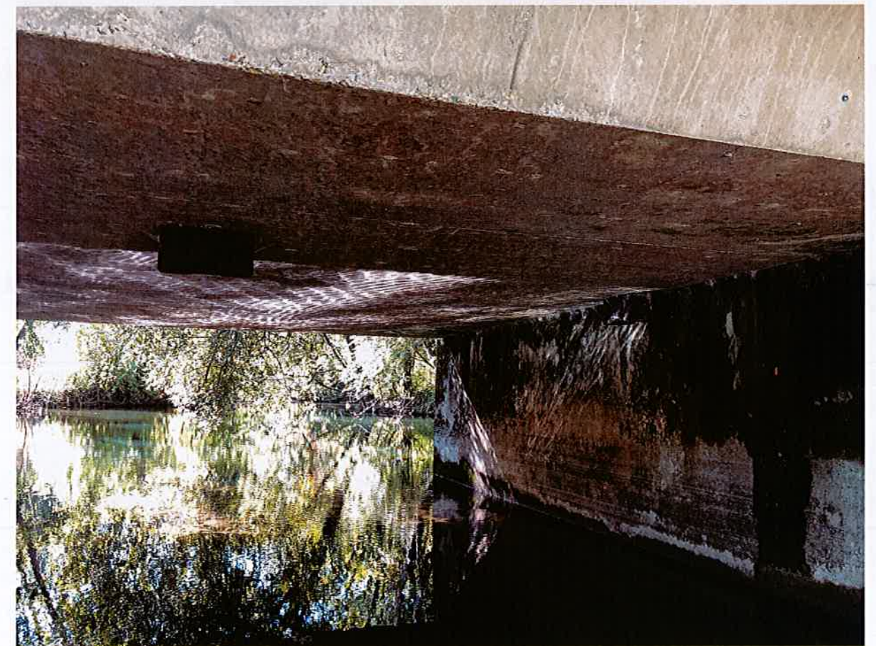
Figure 8 : Gîte artificiel posé sur le pont de la Vaillette
