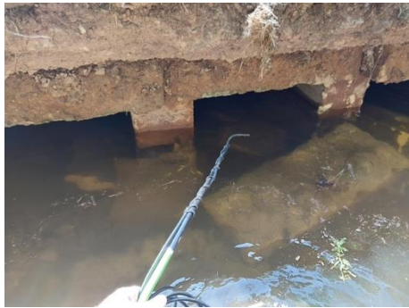
Photo. 14 : pont 7 extérieur (O-GEO, 28/06/2024)
