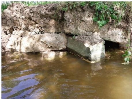
Photo. 12 : pont 6 extérieur (O-GEO, 28/06/2024)
