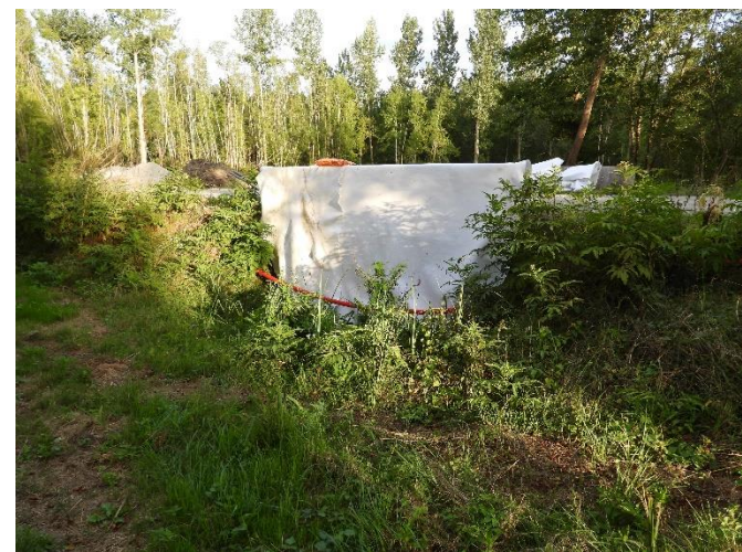
Photo. 23 : face nord du pont 8 avec géotextile posé avant renforcement avec planches et linteaux (O-GEO :04/09/2024)
