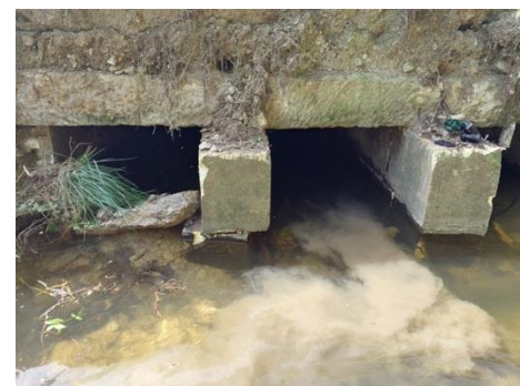
Photo. 1 : pont 1 extérieur (O-GEO, 28/06/2024)
