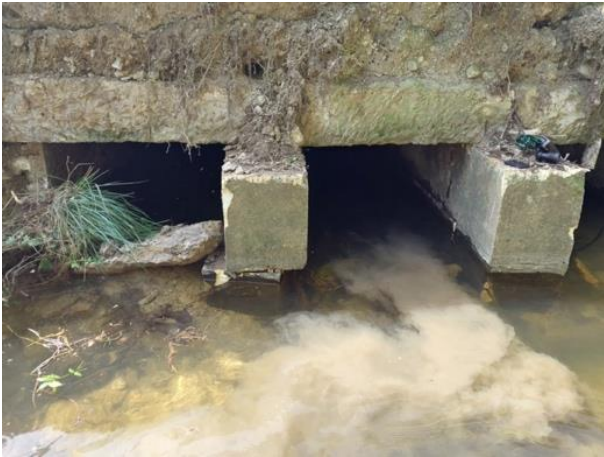
Photo. 1 : pont 1 extérieur (O-GEO, 28/06/2024)
