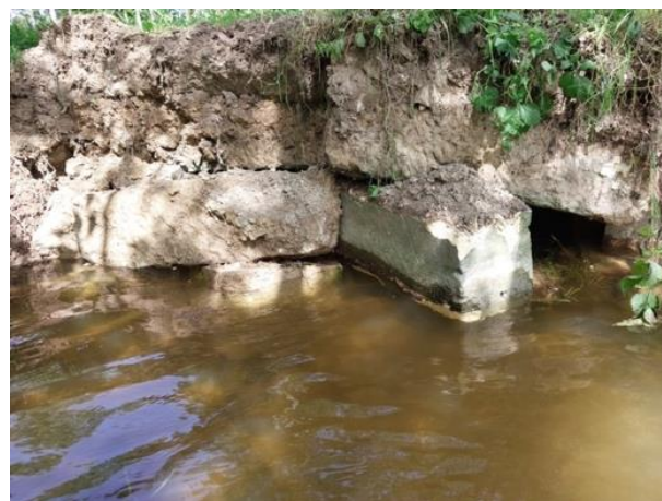
Photo. 12 : pont 6 extérieur (O-GEO, 28/06/2024)
