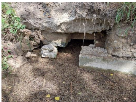
Photo. 10 : pont 5 extérieur (O-GEO, 28/06/2024)
