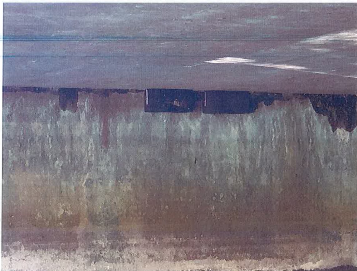
Figure 9 : Gîte artificiel posé sur le pont de la Vaillette
