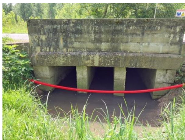
Photo. 15 : pont 8 extérieur (O-GEO, 28/06/2024)
