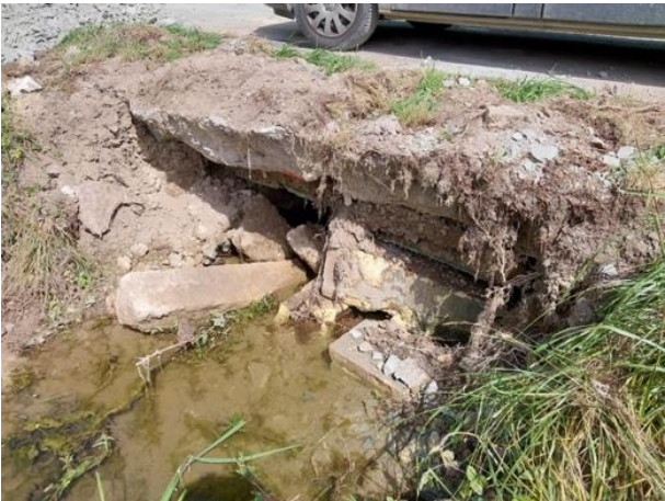
Photo. 6 : pont 3 extérieur (O-GEO, 28/06/2024)
