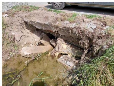
Photo. 6 : pont 3 extérieur (O-GEO, 28/06/2024)
