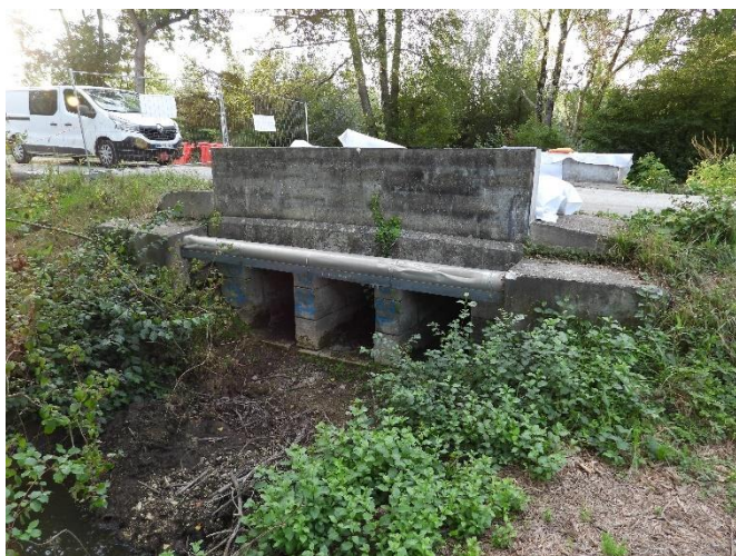
Photo. 24 : face sud du pont 8 laissée en l'état en fin de journée avant l'obturation et du début du canal en aval ( O-GEO :04/09/2024)
