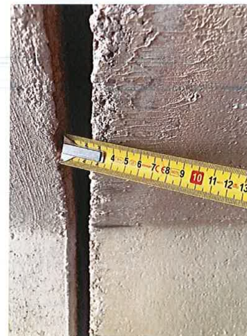
Figure 11 : Zoom sur espacement entre cadre préfabriqué
