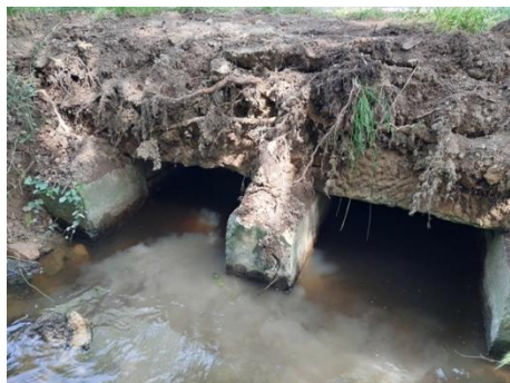
Photo. 7 : pont 4 extérieur (O-GEO, 28/06/2024)
