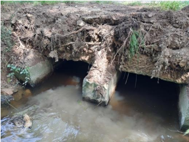
Photo. 7 : pont 4 extérieur (O-GEO, 28/06/2024)
