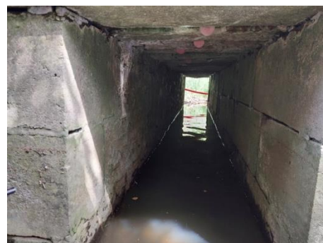
Photo. 16 : pont 8 intérieur d'une arche (O-GEO, 28/06/2024)
