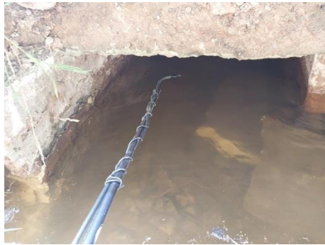
Photo. 13 : pont 7 extérieur (O-GEO, 28/06/2024)
