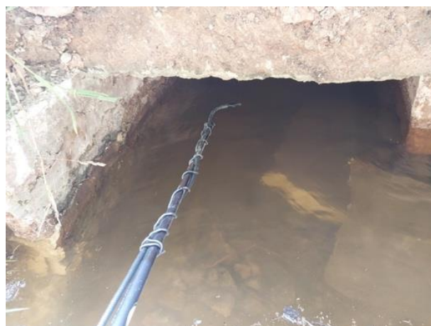
Photo. 13 : pont 7 extérieur (O-GEO, 28/06/2024)
