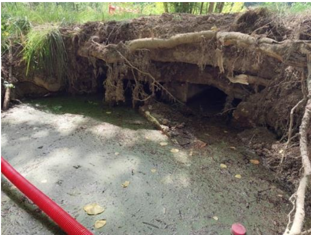
Photo. 9 : pont 5 extérieur (O-GEO, 28/06/2024)
