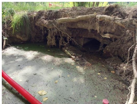
Photo. 9 : pont 5 extérieur (O-GEO, 28/06/2024)
