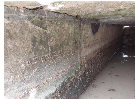
Photo. 3 : pont 2 intérieur d'une arche (O-GEO, 28/06/2024)
