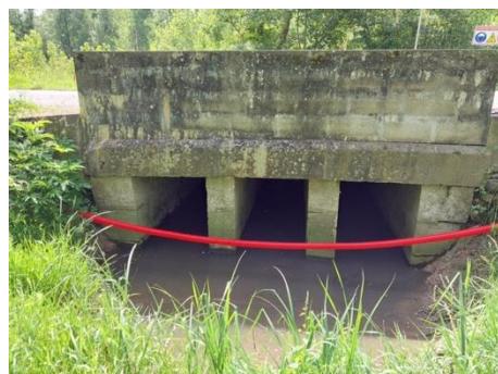
Photo. 15 : pont 8 extérieur (O-GEO, 28/06/2024)
