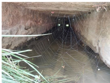
Photo. 2 : pont 1 intérieur d'une arche (O-GEO, 28/06/2024)
