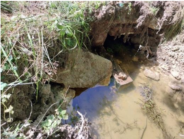
Photo. 5 : pont 3 extérieur (O-GEO, 28/06/2024)
