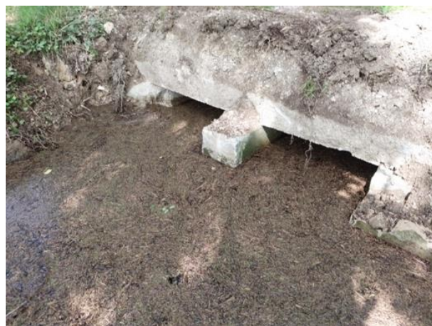
Photo. 11 : pont 6 extérieur (O-GEO, 28/06/2024)
