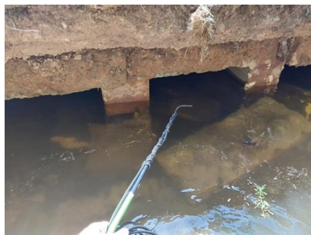
Photo. 14 : pont 7 extérieur (O-GEO, 28/06/2024)
