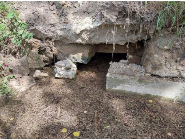
Photo. 10 : pont 5 extérieur (O-GEO, 28/06/2024)
