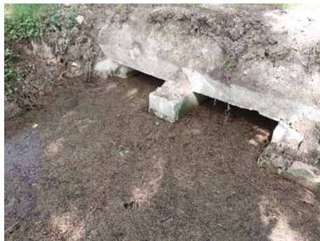
Photo. 11 : pont 6 extérieur (O-GEO, 28/06/2024)
