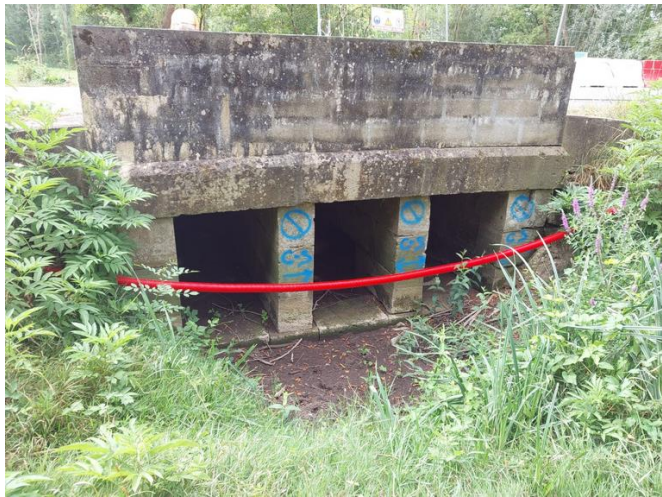
Photo. 20 : pont 8 contrôlé (O-GEO, le 14/08/2024)
