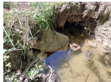
Photo. 5 : pont 3 extérieur (O-GEO, 28/06/2024)
