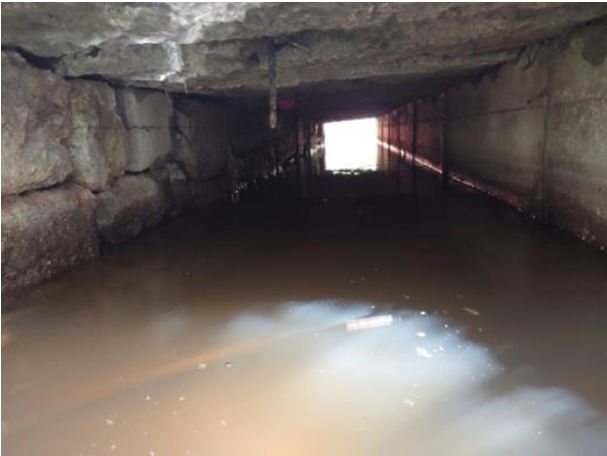
Photo. 8 : pont 4 intérieur d'une arche (O-GEO, 28/06/2024)
