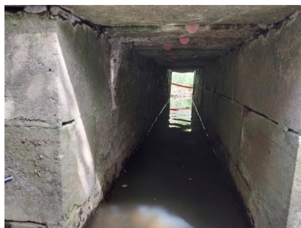
Photo. 16 : pont 8 intérieur d'une arche (O-GEO, 28/06/2024)
