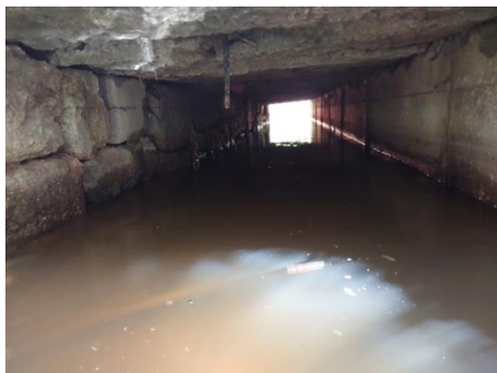
Photo. 8 : pont 4 intérieur d'une arche (O-GEO, 28/06/2024)
