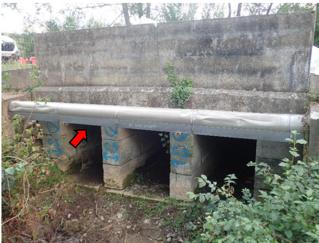
Photo. 25 : face sud du pont 8 et localisation de la colonie (O-GEO :04/09/2024)
