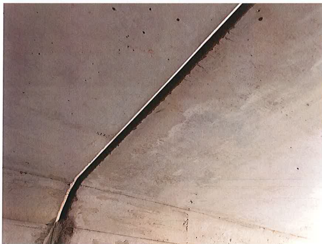
Figure 10 : Espacement entre cadre préfabriqué
