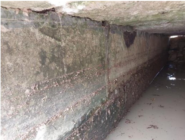
Photo. 3 : pont 2 intérieur d'une arche (O-GEO, 28/06/2024)
