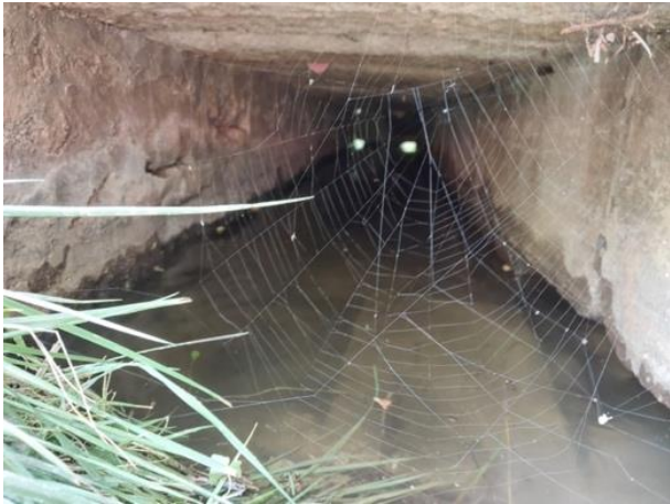
Photo. 2 : pont 1 intérieur d'une arche (O-GEO, 28/06/2024)
