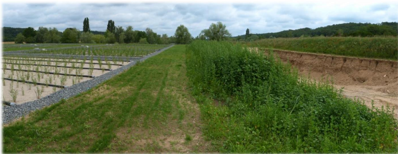
Figure 1 : Vue sur la nouvelle station d'épuration (à gauche) et la zone d'emprunt de matériaux colonisée (à droite)
