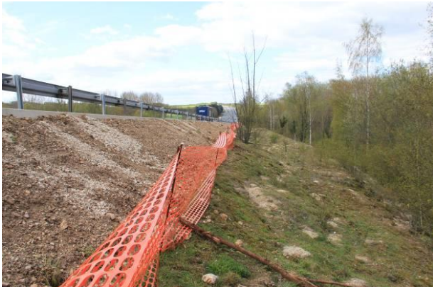
Mise en défens à l'aide de filet de protection sur un chantier autoroutier (A11, Cofiroute)
