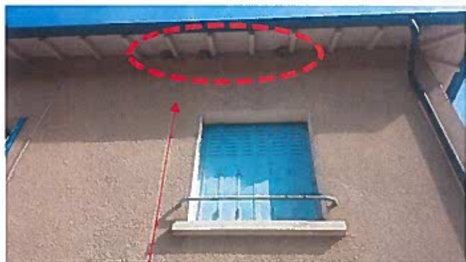
3 nids sous l'avant-toit de la façade Sud
