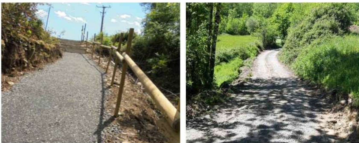
Figure 13: Accès piéton à gauche et accès pour les engins à droite (photos chantier de 2019)
