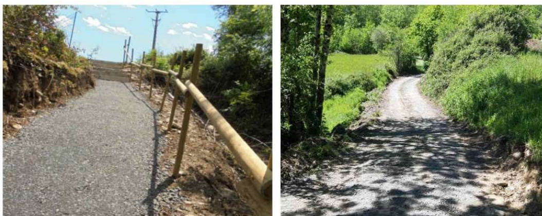
Figure 26: Accès piéton entre la base-vie et la zone de travaux (à gauche) et accès pour le passage des engins jusqu’à la zone de chantier (à droite)
