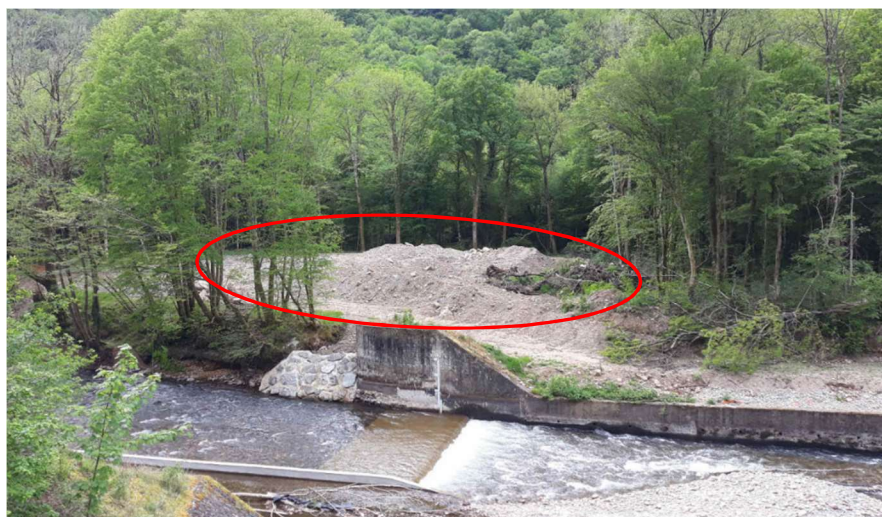
Figure 14: Vue de la RG de la Maronne au droit du seuil
