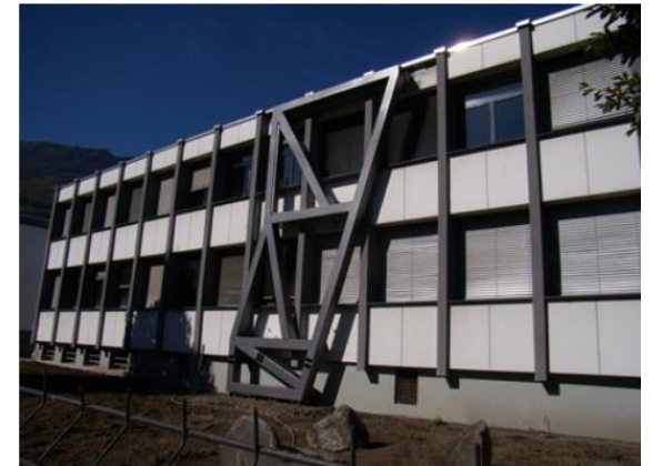
Renforcement d'un collège en Suisse, source : Kcing.ch
