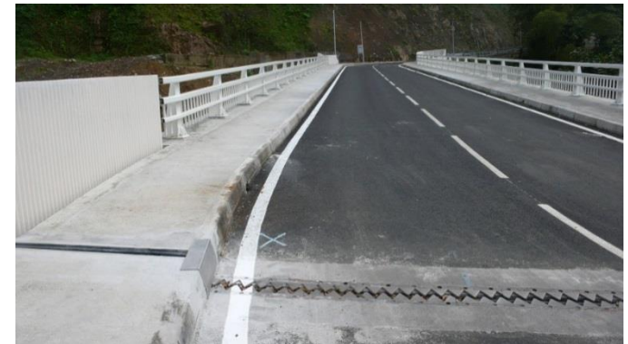
Pont parasismique (Martinique) avec joints et amortisseurs joignant les culées au tablier
