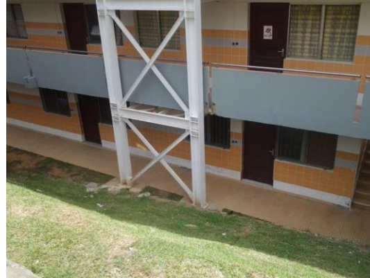
Contreforts béton et contreventements acier sur immeubles, Martinique, source : Replik972.fr
