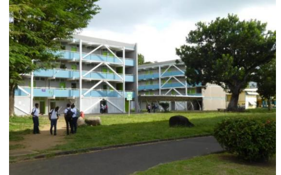
Contreforts béton et contreventements acier sur immeubles, Martinique, source : Replik972.fr
