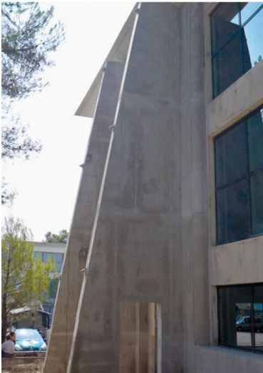
Contreforts liaisonnés à la structure, Sophia Antipolis ; source: freyssinet.com
