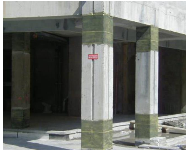
Renforcement de nœuds poteau-poutre par des renforts composites ; source: freyssinet.com
