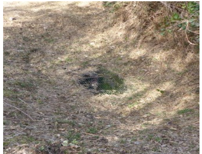
Figure 13 : regard de la canalisation en aval de la confluence des eaux du ruisseau et des eaux minières
