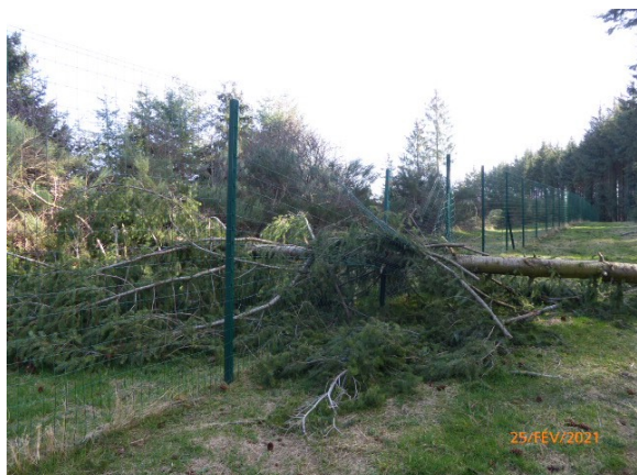
Figure 6 : clôture endommagée par une chute d'arbre
