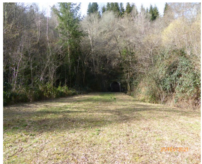
Figure 10 : état général de la zone clôturée
