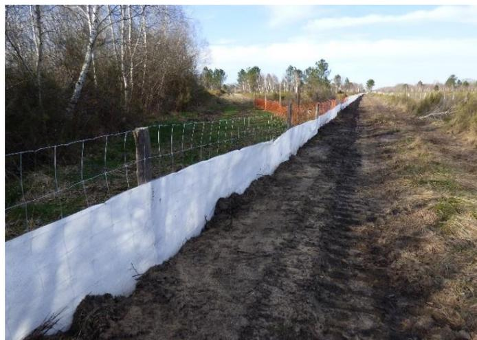
Figure 51 : Bâche géotextile semi-enterrée mise en place sur le chantier routier de la déviation du Taillan-Médoc
