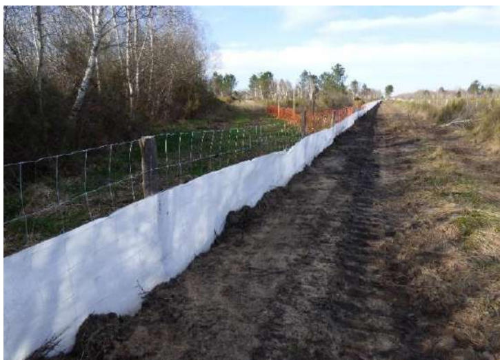
Figure 67 : Bâche géotextile semi-enterrée mise en place sur le chantier routier de la déviation du Taillan-Médoc
