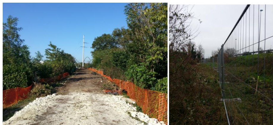
Différents types de clôtures de chantier (Source : Erea conseil)
