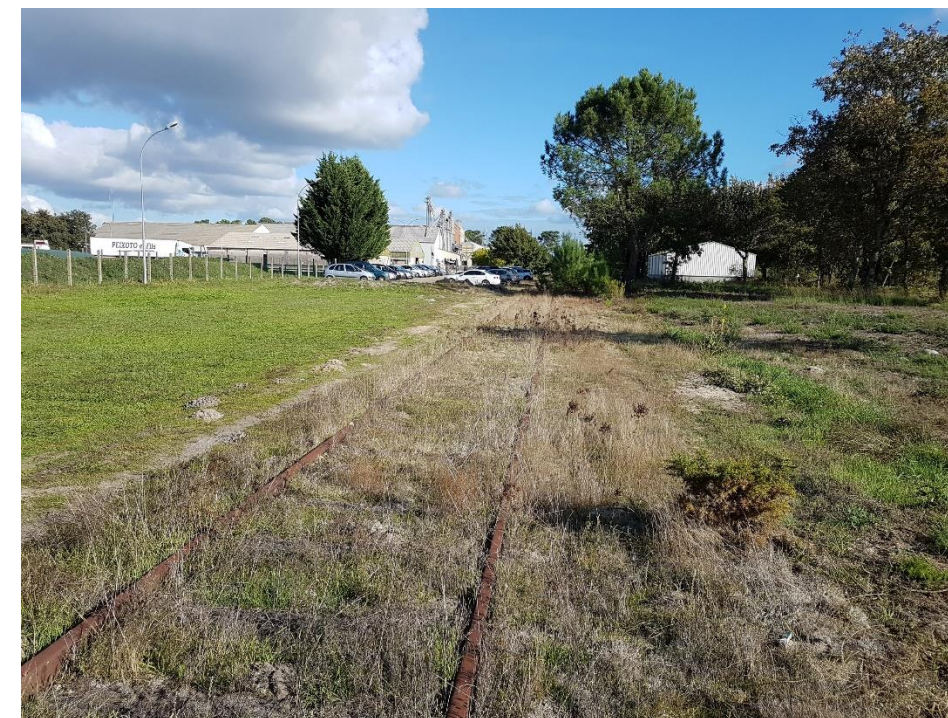
Illustration 14. Friche ferroviaire sur sable © SYSTRA
