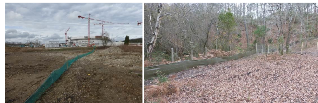
Exemples de barrières anti-batraciens ceinturant un chantier de construction (Source : Simethis)
