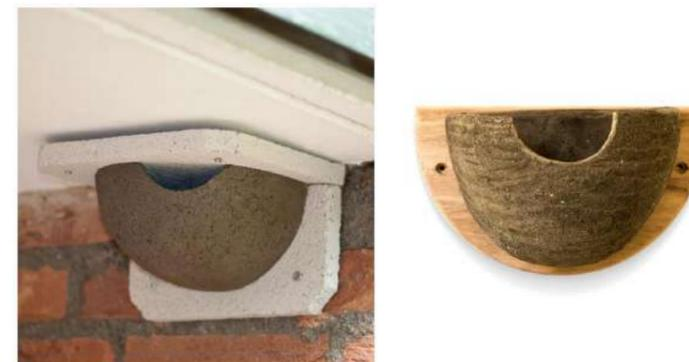
Figure 12 : Exemples de nids artificiels envisageables : A gauche, nichoir WoodStone® (béton /bois) de chez Vivavara. Une vigilance est cependant à porter sur la bonne orientation de l'entrée du nid, celle-ci étant ici légèrement déportée. A droite, nichoir en céramique de la LPO. Ce modèle nécessite que sa partie haute soit bien plaquée sur l'encadrement de fenêtre.
