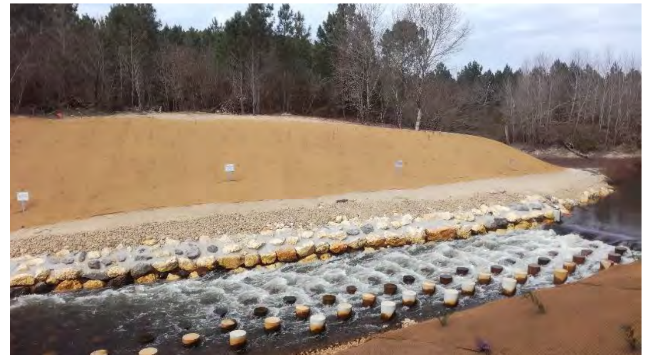
Figure 14 : Exemple de passe à macro-rugosité (rampe en enrochements régulièrement répartis) sur le curant de Sainte Eulalie
