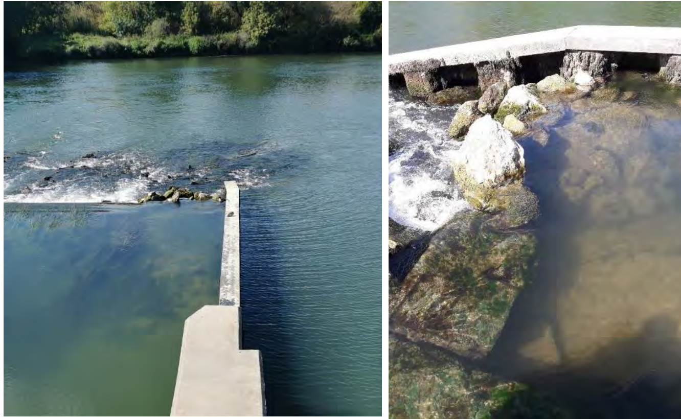
Figure 12 : Vues de la connexion entre le déversoir et le barrage
