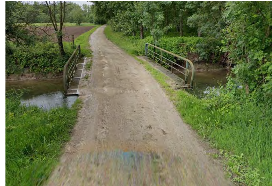
Figure 2 - Ouvrage de franchissement du Bras de la Seugne à la Charente (source : Google Street View)
