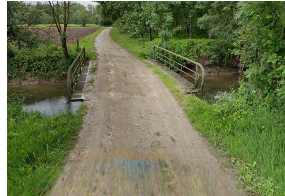
Figure 22 : Ouvrage de franchissement du Bras de la Seugne à la Charente (source : Google Street View)
