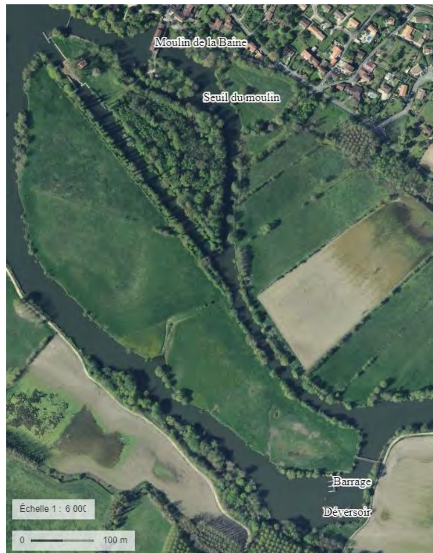
Figure 2 : Complexe hydraulique de la Baine
