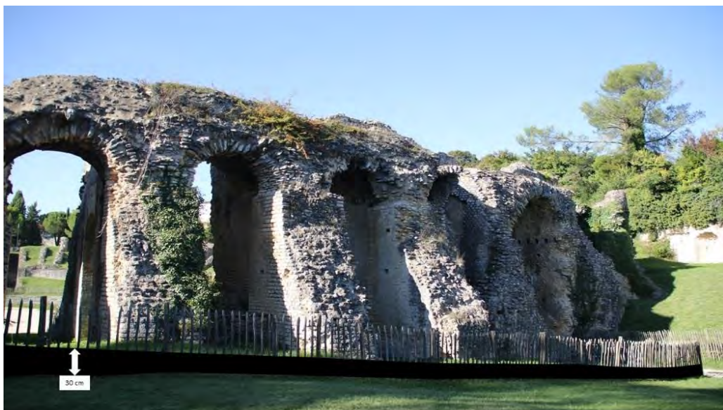
Figure 4 Photomontage de la barrière à amphibiens positionnée sur site (côté porte des vivants)
