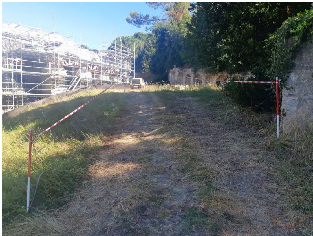
Figure 42 Photographie de l'accès au chantier de la porte des vivants (source : ECR environnement)
