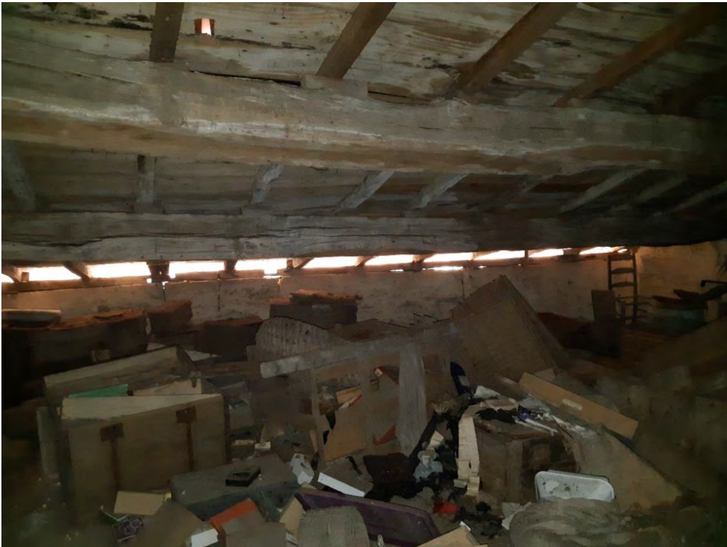
Lucarnes de la maison Audiat à combler partiellement (laisser 2 lucarnes faisant office de chiroptière naturelle)
