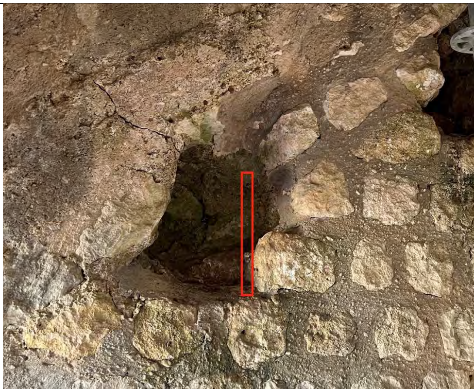
Figure 60 Localisation du positionnement d'une faille à créer dans un trou de boulin
