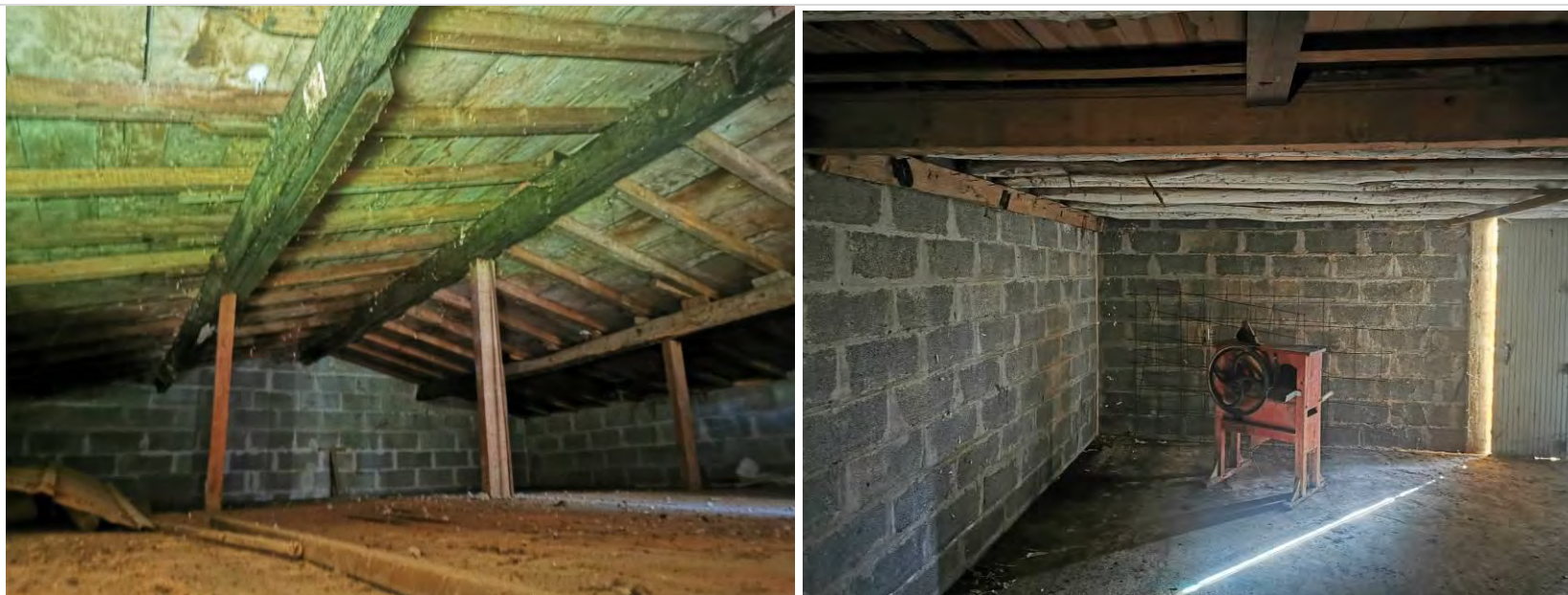
Photo 13 : Garage présentant des interstices dans la charpente et le plancher des combles
