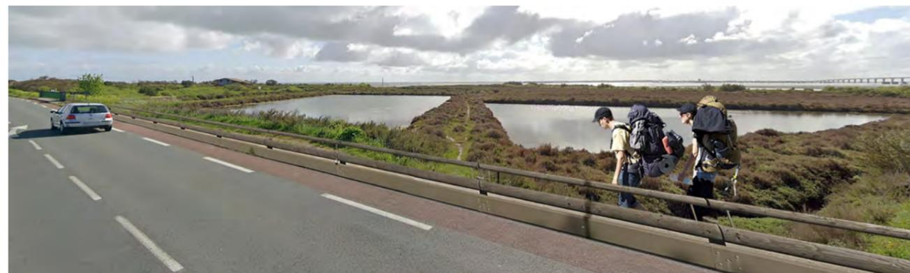
Figure 47 : Illustration du scénario 1 : Glissière de sécurité habillage bois en accotement de la RD 793
