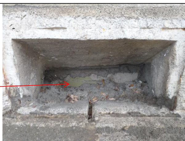
Détail d'un soupirail condamné M3
