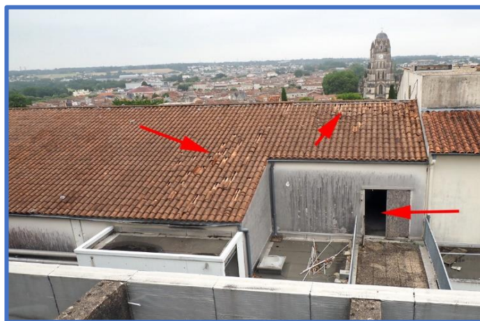
Accès comble et toiture (tuiles manquantes)
