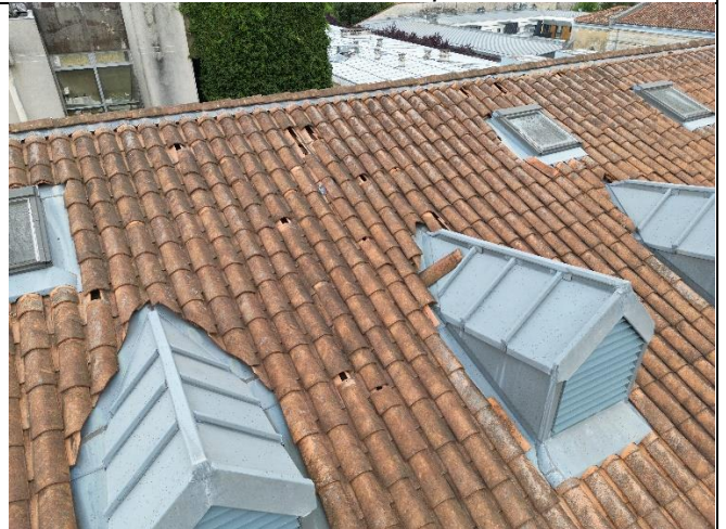
Tuiles cassées - M3 par drone
