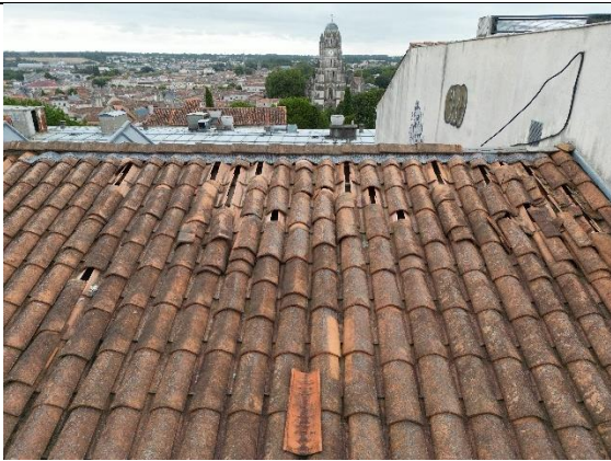
Tuiles cassées - M3 par drone
