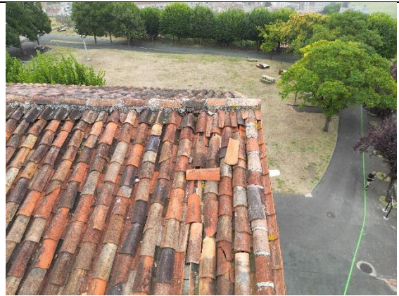
Tuiles cassées - M3 par drone
