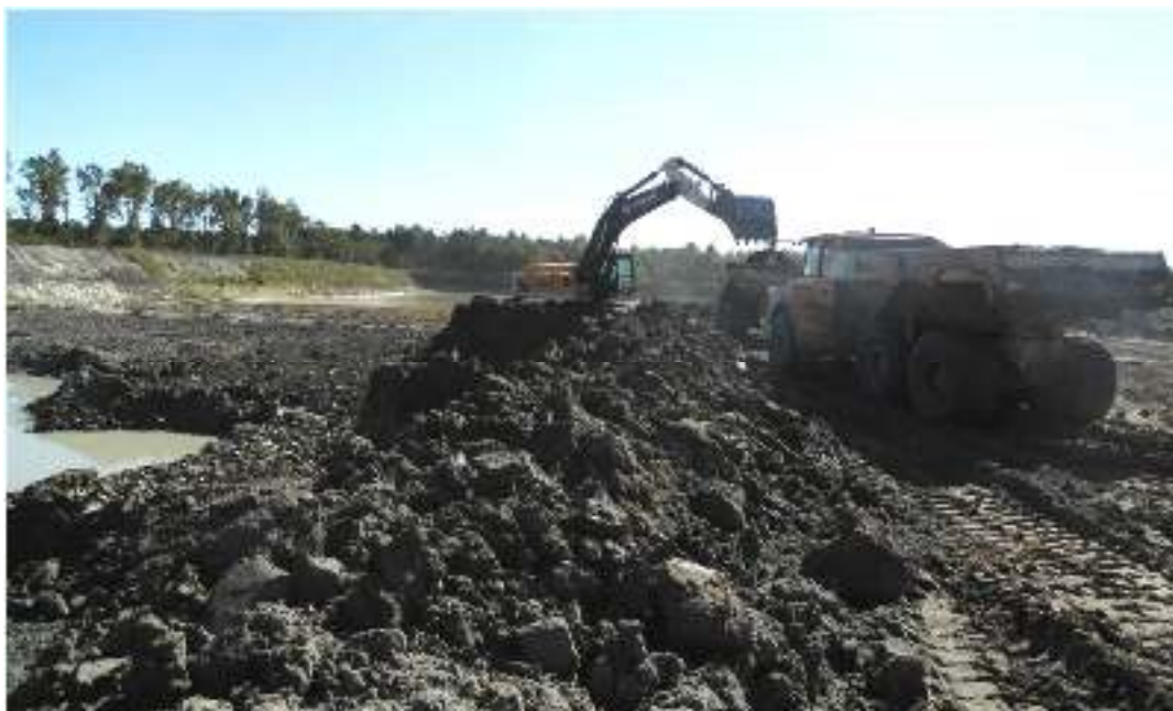
Décapage et tri des terres végétales.
