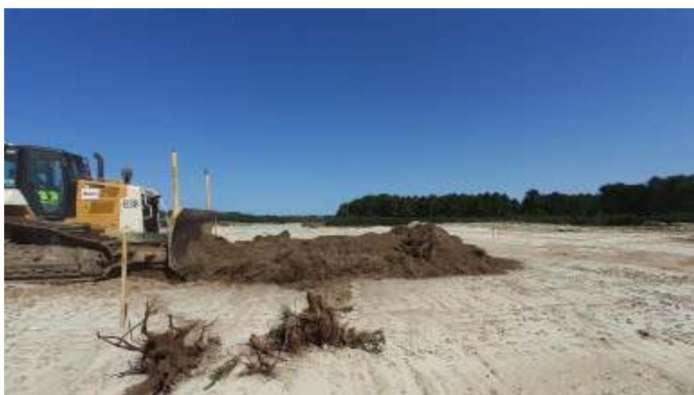
Figure 7 Régalage de la terre végétale par un bulldozer
