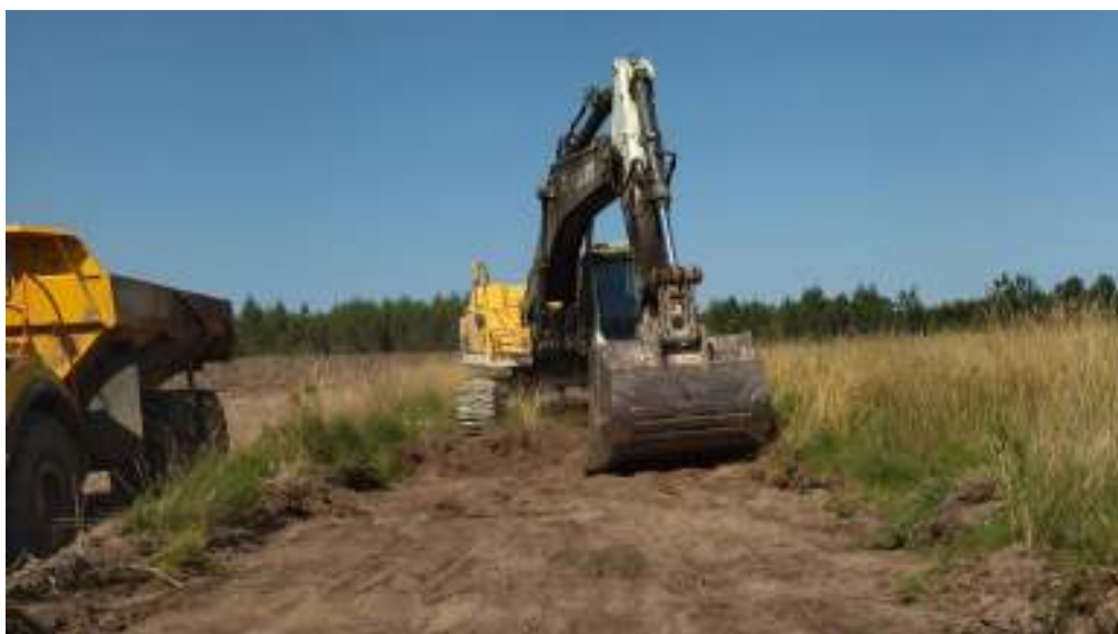
Figure 5 Décapage de la terre végétale
