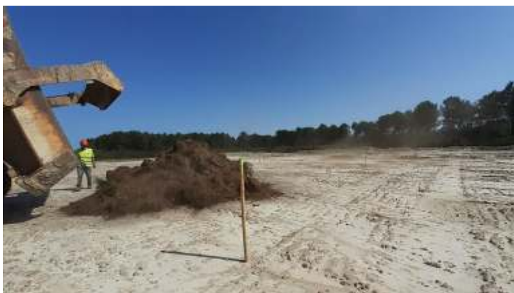
Figure 6 Apport de la terre végétale par un tombereau
