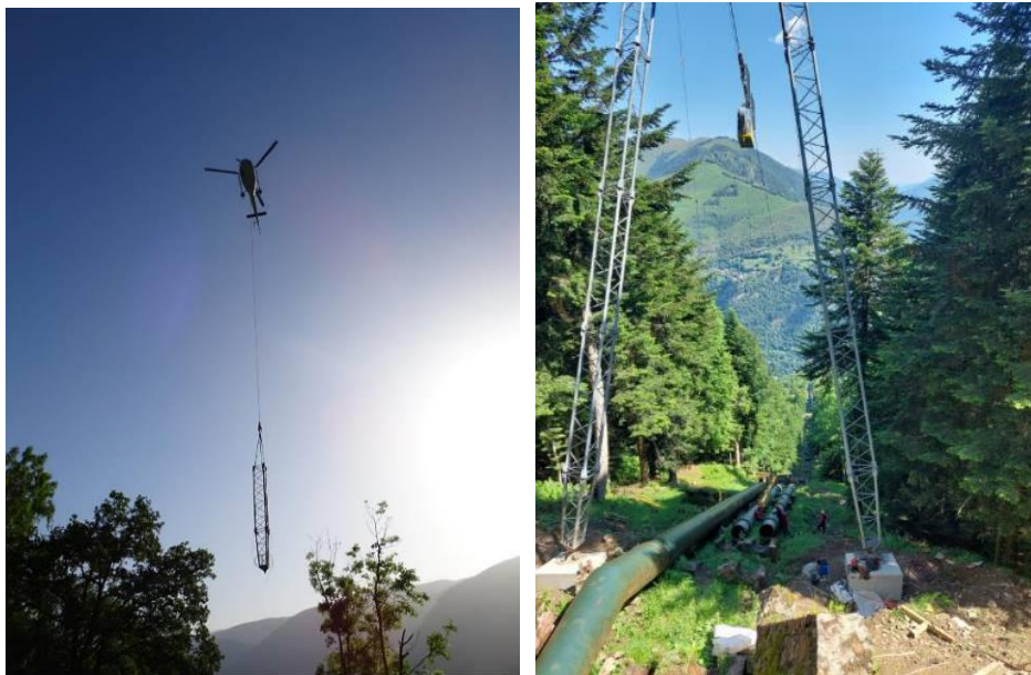
Figure 44 : Exemple mise en œuvre des poteaux haubanés (travaux EDF Lac d'Oo)
