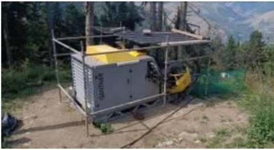
Figure 45 : Chantier du Lac d'Ôo : treuil principal & tour d'échafaudage
