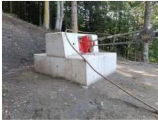
Figure 43 : Exemple de massif d'ancrage (travaux EDF Lac d'Oo)
