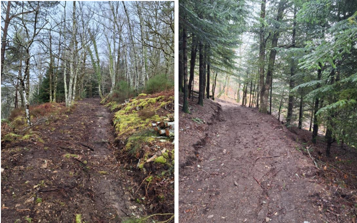
Figure 17 : Création de l'accès pour l'acheminement de la foreuse
