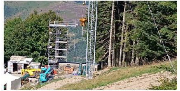
Figure 45 : Chantier du Lac d'Ôo : treuil principal & tour d'échafaudage
