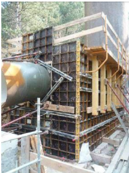
Figure 53 : Chantier de la CF de Madières coffrage à gauche et massif terminé à droite
