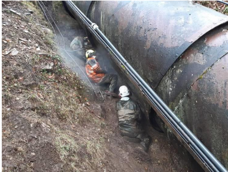
Figure 16 : Illustration des travaux de dégagement sous la CF
