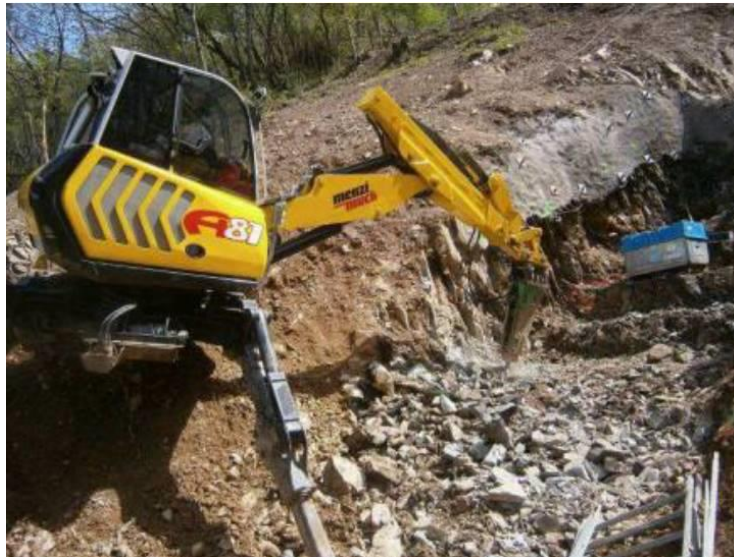
Figure 51 : Illustration de l'utilisation d'une pelle araignée sur un massif (Chantier EDF CF Aston)
