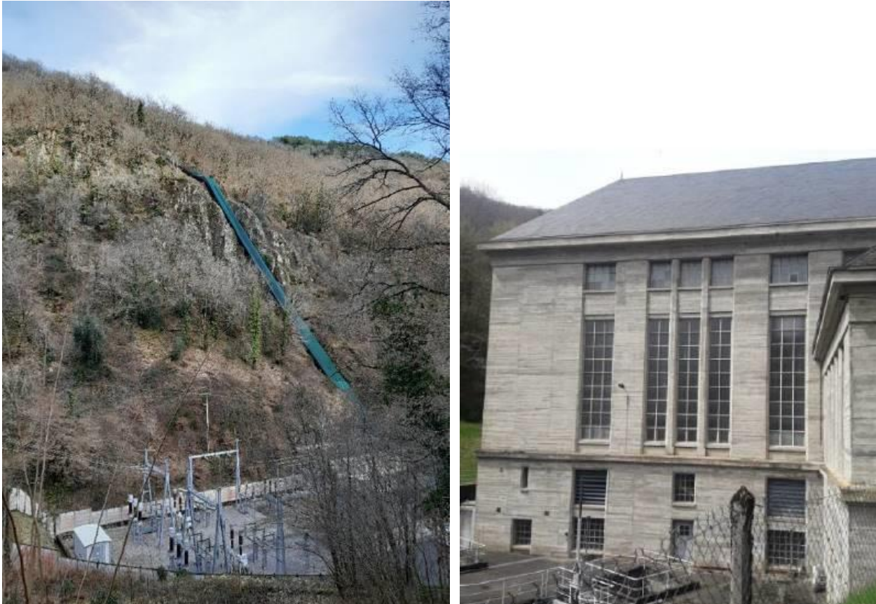
Figure 3 : Conduite Forcée en partie basse (à gauche) et usine de Marcillac (à droite)
