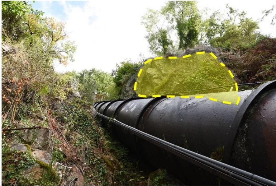
Figure 107 : Etendue de la station d'Orpin hérissé sur le secteur amont, déjà sécurisé
