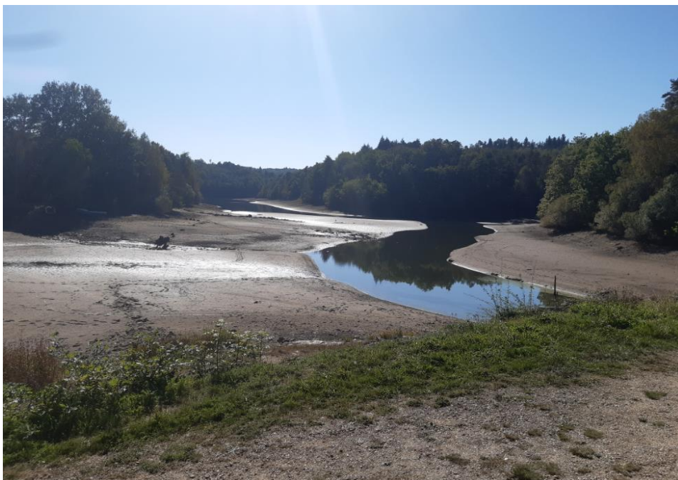
Figure 91 : Photo de la retenue de Marcillac en queue de retenue le 11 10 23
