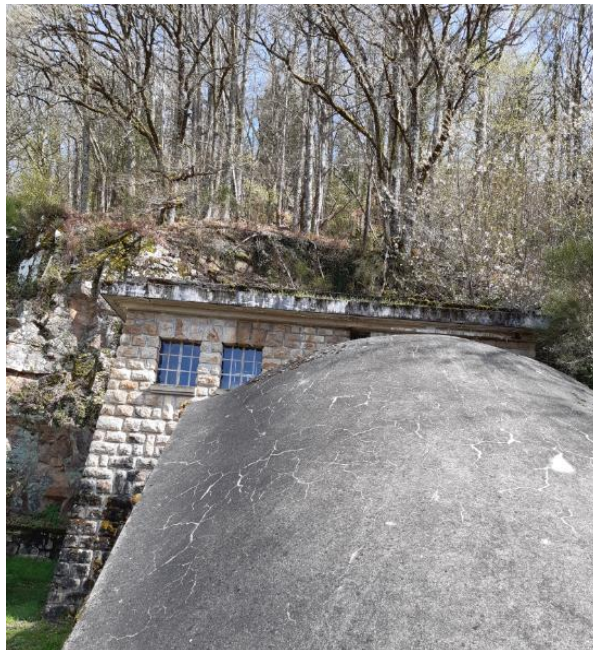
Figure 75 : Habitats au-dessus de la vanne de tête
