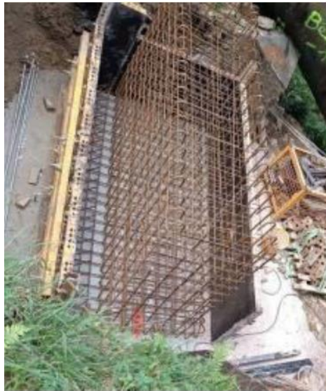
Figure 52 : Chantier EDF du Lac d'Ôo coffrage / Ferrailage d'une pilette (à gauche) & pilette post-décoffrage (à droite)
