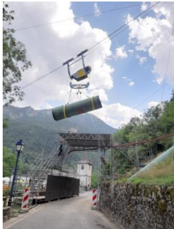
Figure 79 : Illustration fonctionnement blondin avec virole (chantier EDF Saint Lary Soulan 2020-2021)
