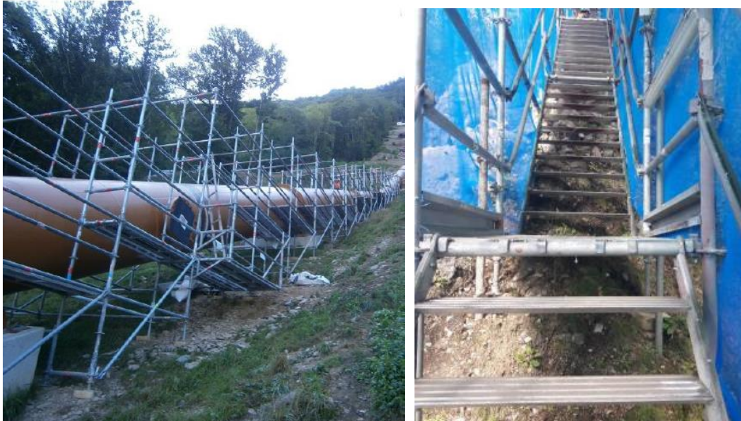
Figure 81 : Illustration de la faible emprise de l'échafaudage pendant le chantier EDF d'Aston et de Sabart
