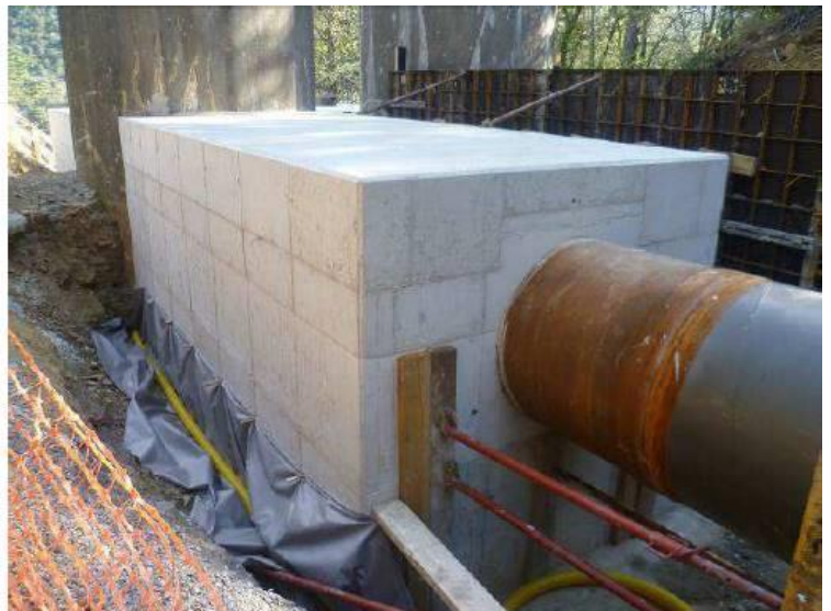
Figure 53 : Chantier de la CF de Madières coffrage à gauche et massif terminé à droite
