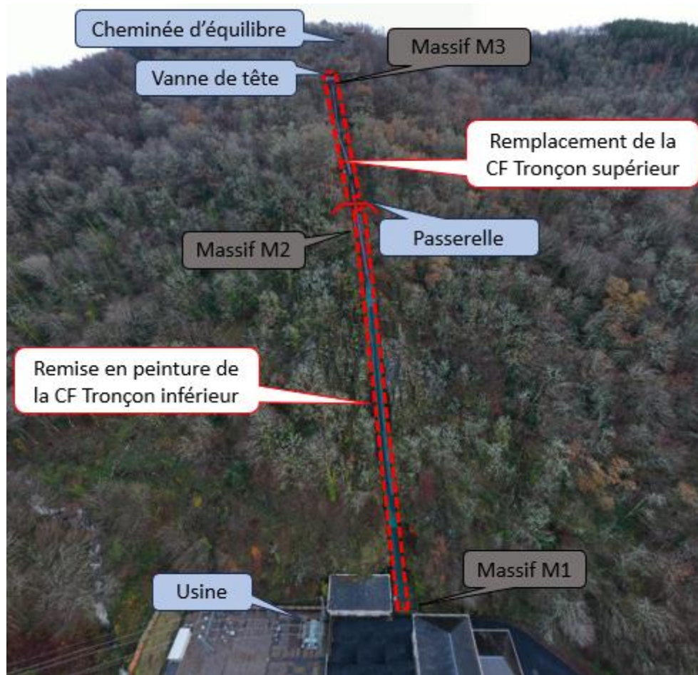
Figure 4 : Vue d'ensemble du projet Marcillac
