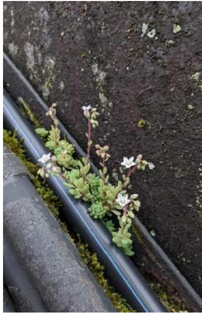
Figure 86 : Emprise de l'échafaudage et présence de station d'Orpin hérissé
