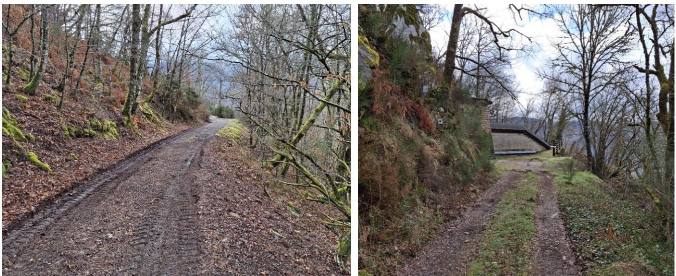
Figure 58 : Chemin accès Vanne de Tête
