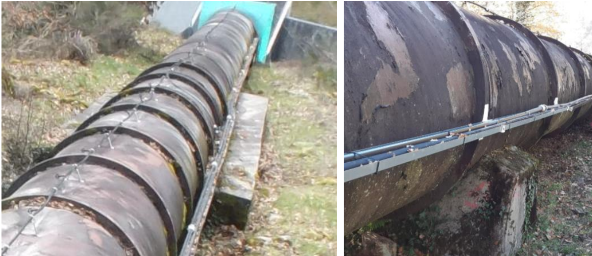
Figure 37 : Massif M2 et pilette (en amont de la passerelle)
