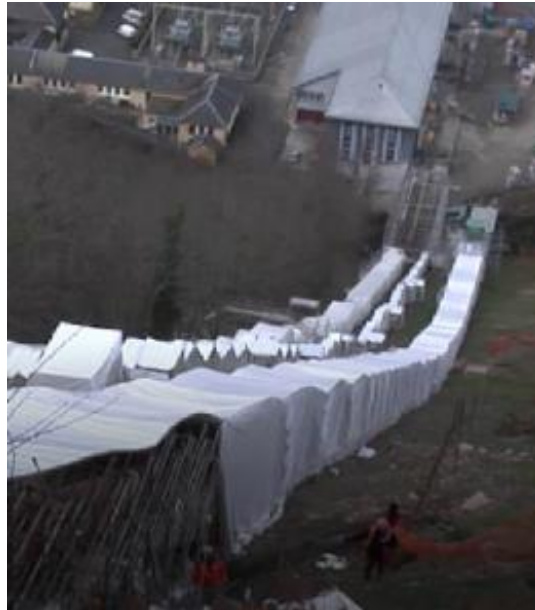
Figure 82 : Illustration du confinement, chantier EDF CF Aston
