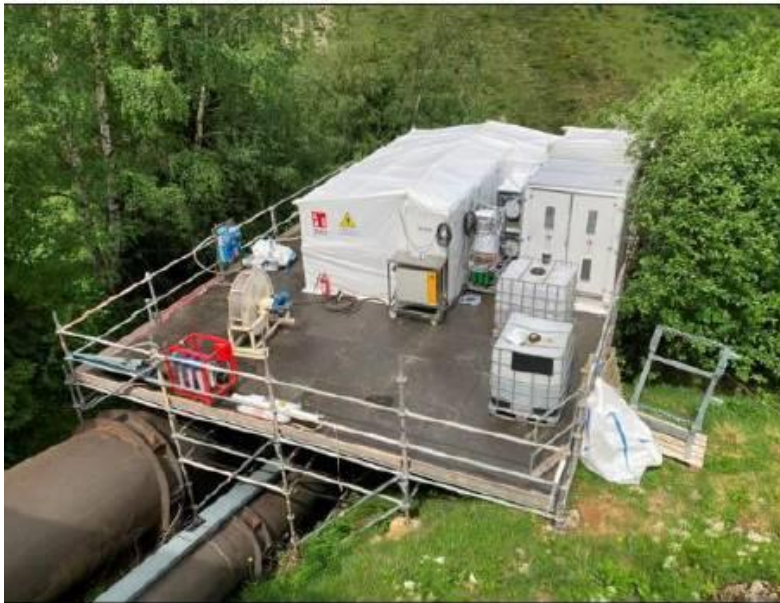
Figure 63 : Exemple d'installation d'une zone d'accès à la zone confinée (chantier EDF CF Bésines 2022)
