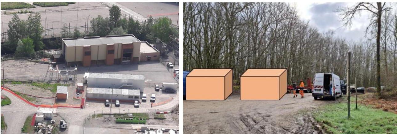
Figure 71 : Installation d'une base vie et zone de stockage dans une cour de l'usine (chantier EDF Sabart 2018-2020) & schéma de principe de la base vie amont
