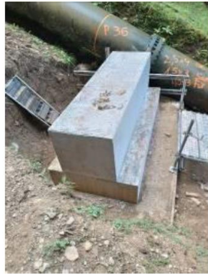
Figure 52 : Chantier EDF du Lac d'Ôo coffrage / Ferrailage d'une pilette (à gauche) & pilette post-décoffrage (à droite)
