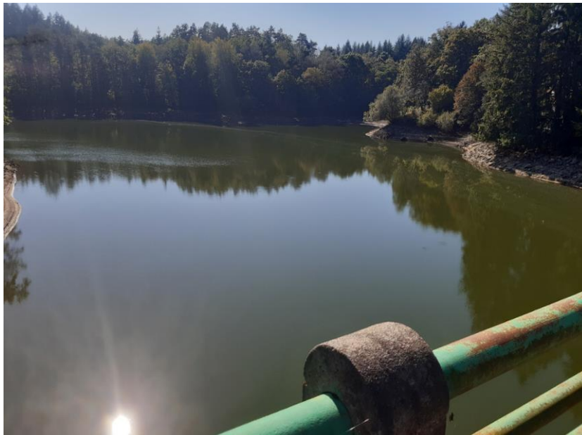
Figure 89 : Photo de la retenue de Marcillac le 11 10 23
