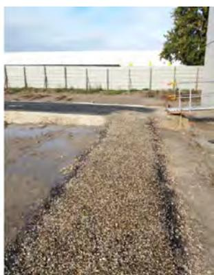
Dispositif pour limiter la dispersion des boues
