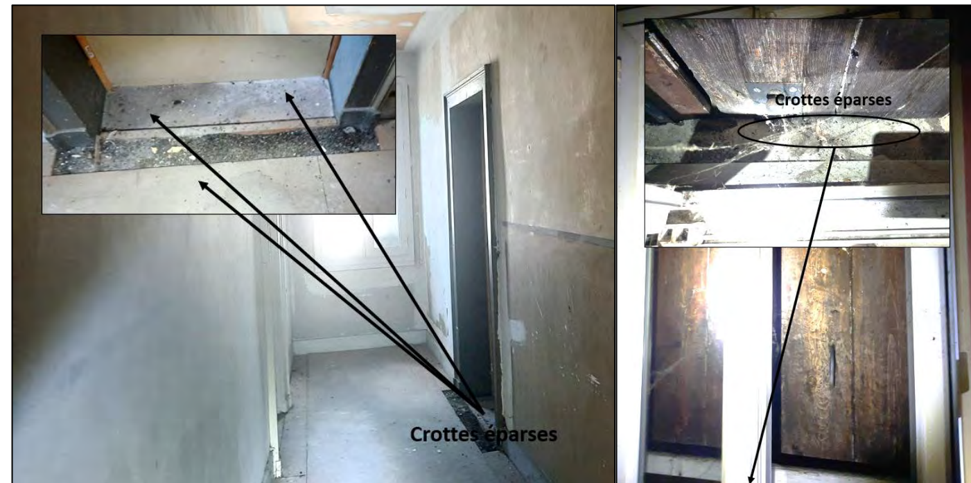
Figure 58 : Exemple de crottes inventoriés au niveau de l'ancienne bâtisse et au niveau d'une fenêtre appartenant à cette dernière
