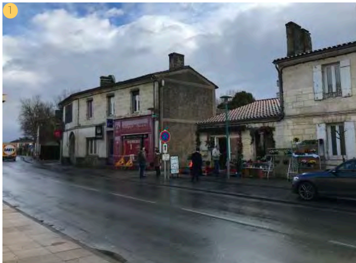
Vue de la façade depuis l'avenue du Général de Gaulle. Accès au local commercial depuis l'avenue.
