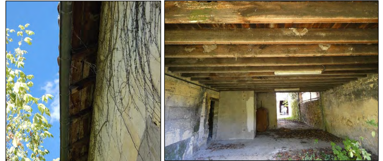
Figure 46 : Voliges de bord de toiture (à gauche) et toiture de la terrasse semi-ouverte (à droite)
