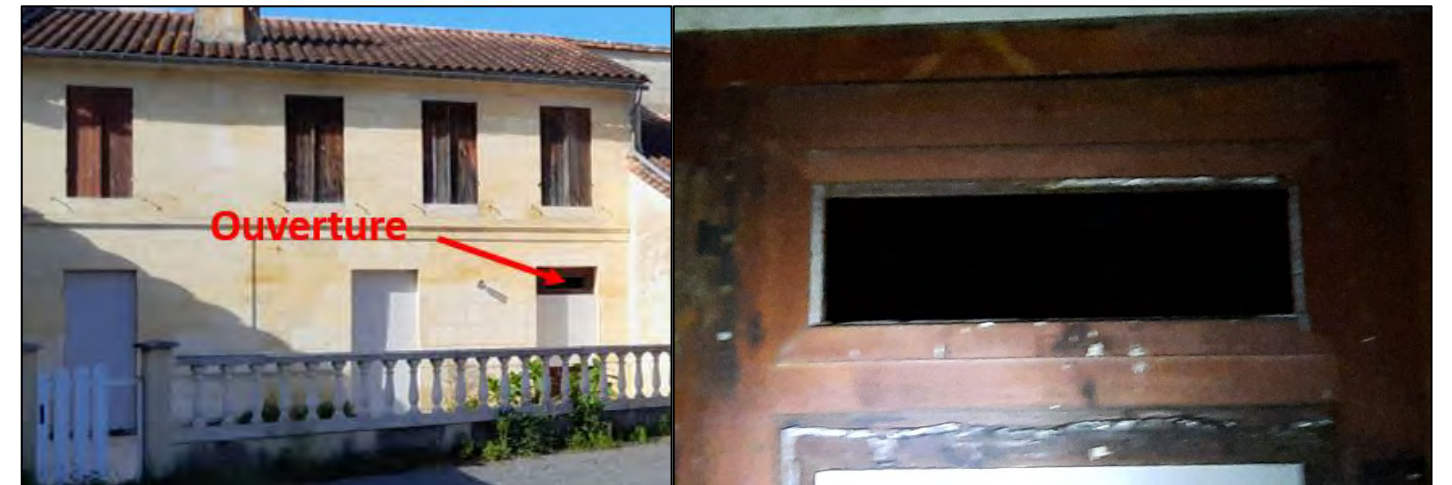
Figure 59 : Ouverture permettant l'accès à l'ancienne bâtisse
