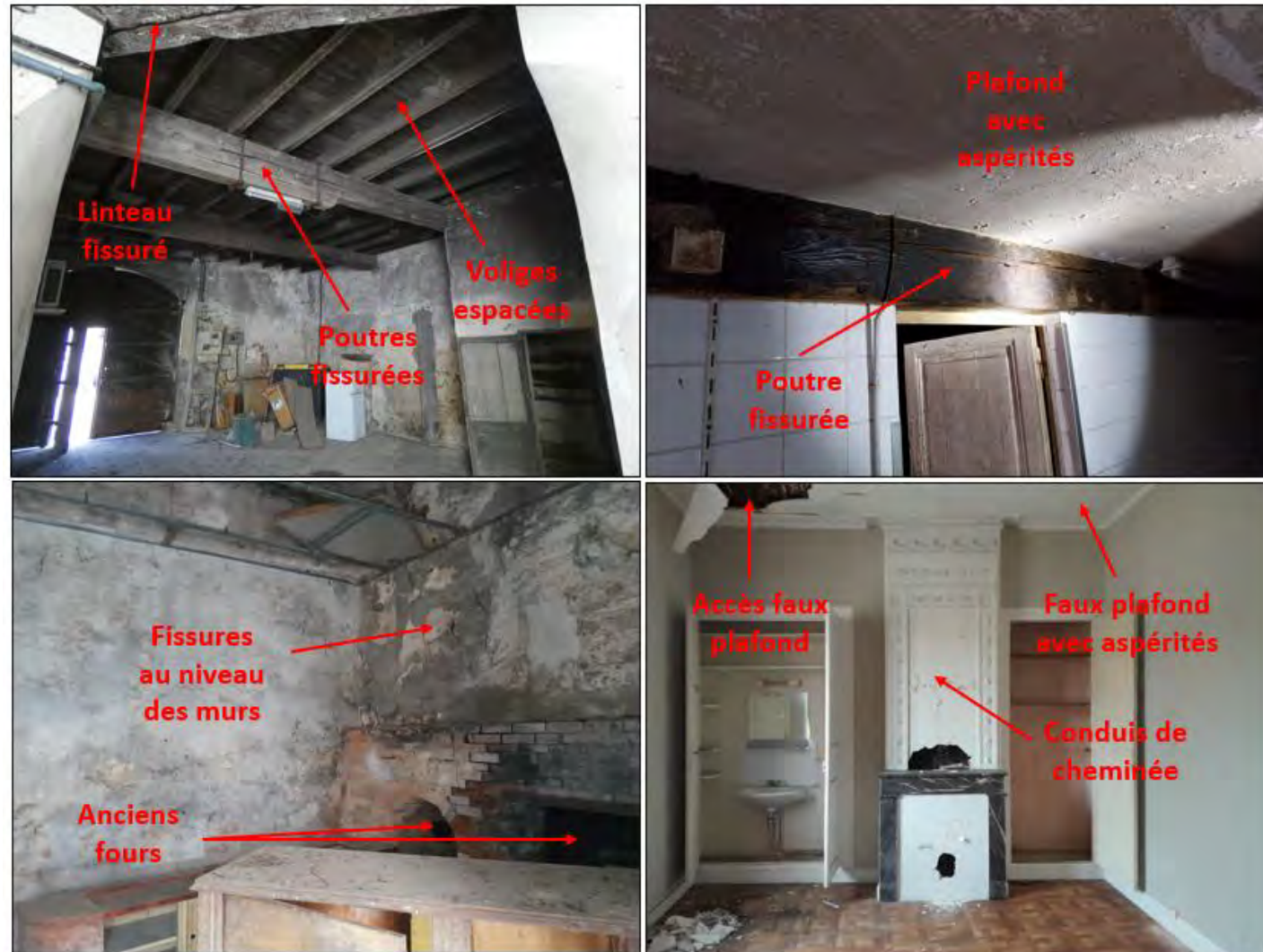
Figure 48 : Exemples de gîtes potentiels présents au sein des bâtiments
