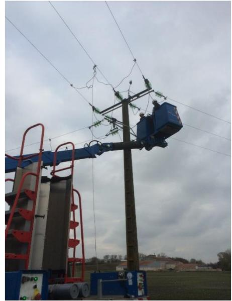
*Figures 16 & 17 : Installation d'un anémomètre sur un poteau double ancrage (photo de gauche de 2014). Désormais, le matériel a été adapté et une rallonge a été rajoutée car on voit la dimension de ce poteau double ancrage très grand (ENEDIS Poitou-Charentes & Nicolas GENDRE / LPO).*
