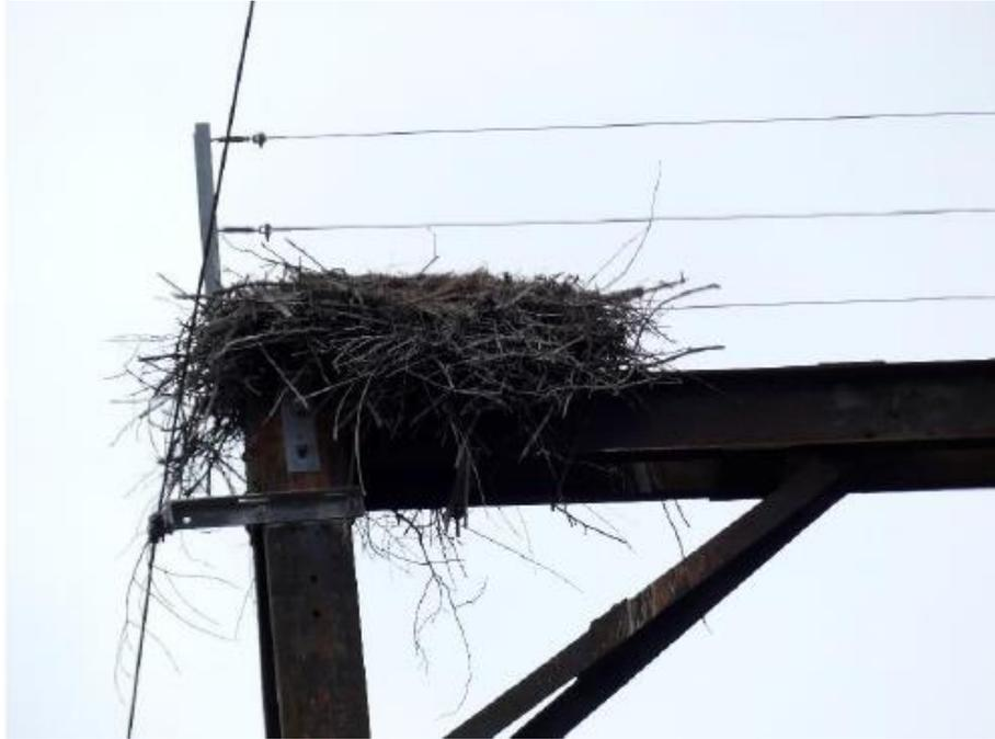
*Figure 40 : Nid de Cigogne blanche construit sur un poteau caténaire à Arveyres malgré la pose de câbles (J. Lazard)*
