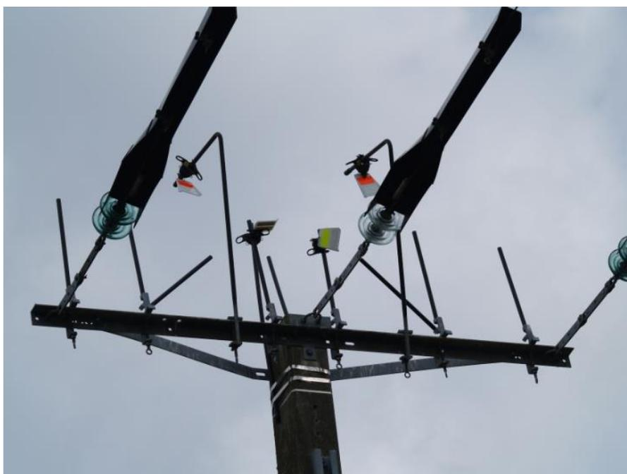
*Figure 13 : Dispositif installé sur un poteau électrique pour empêcher l'oiseau de revenir nicher après le déplacement de son nid (2012), avant l'adoption de l'anémomètre par ENEDIS Poitou-Charentes (Nicolas GENDRE / LPO)*
