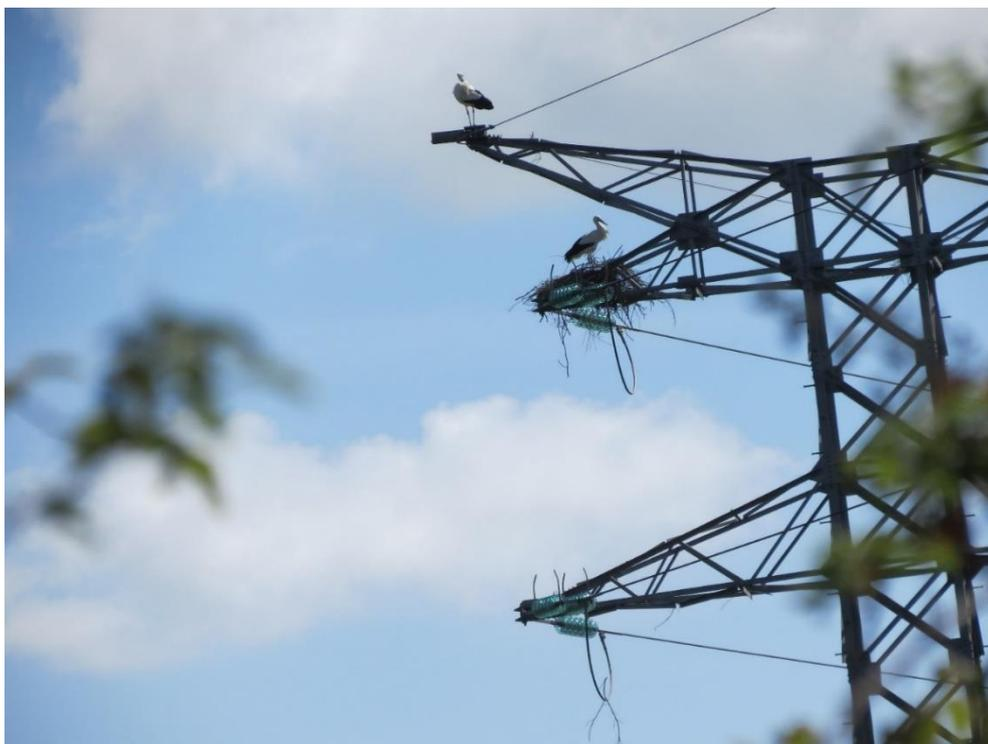
*Figure 37 : Exemple d'un nouveau nid de Cigogne blanche en construction sur un pylône RTE avec de nombreuses branches tombant sur les phases en dessous, pouvant provoquer des microcoupures. Avril 2023 – Secteur de Saintes – Charente-Maritime (Nicolas GENDRE / LPO).*
