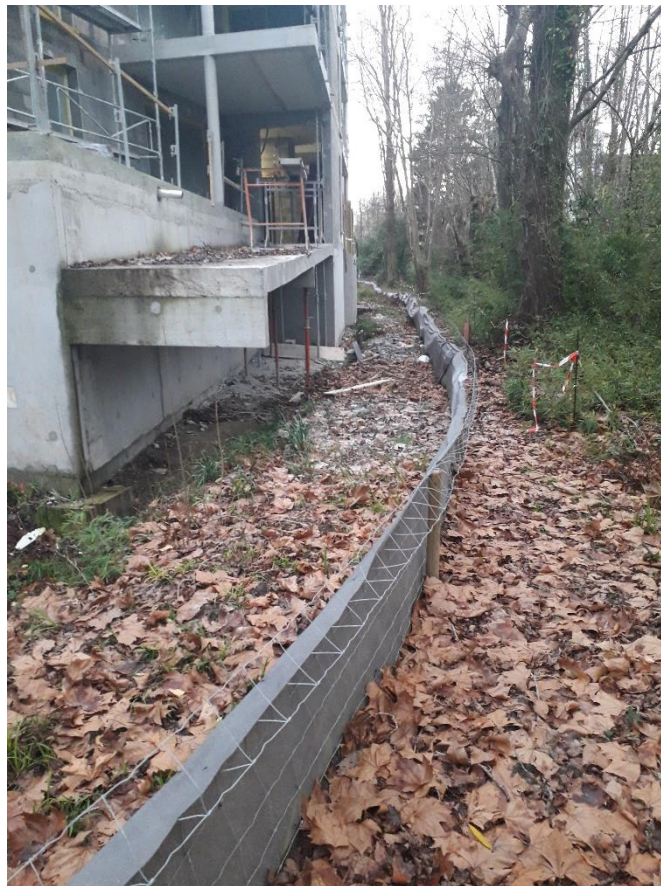
Maintien de l'entretien de la végétation et du bon état des clôtures décembre 2020
