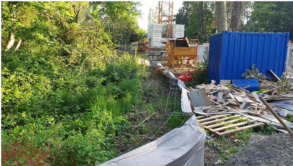
Figure 16 : Clôture à amphibiens avec bavolet érigées autour de l'emprise chantier (Source : GEOCIAM)
