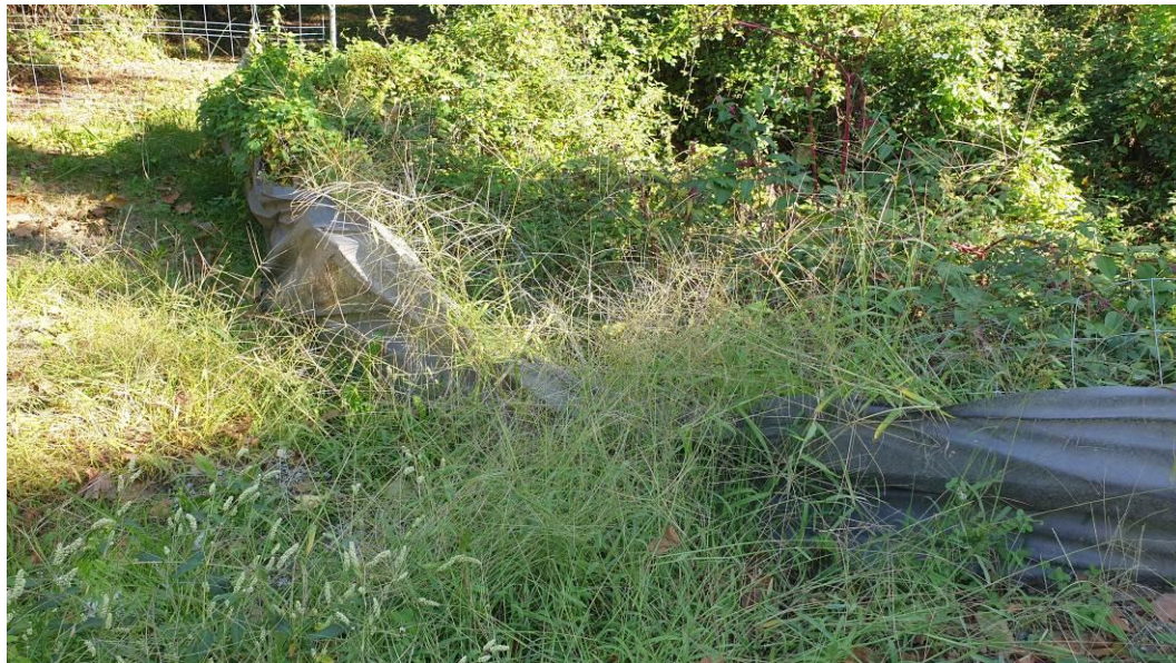
Clôture affaissée par le poids de la végétation (septembre 2020)
