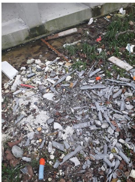
Débris de chantier
