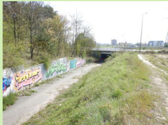
Mur de soutènement – lieu de thermorégulation
