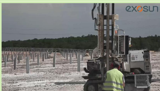
Montage des fondations (exemple de photos d'Exosun)
