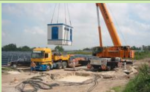
Pose des postes de conversion (source : NEOEN)
