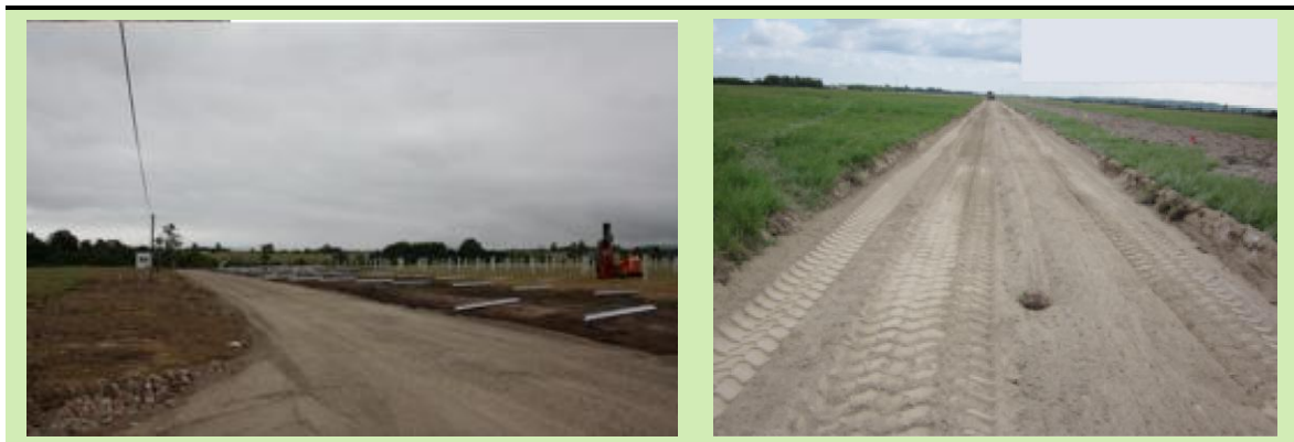
Réalisation des pistes d'accès (source : NEOEN)
