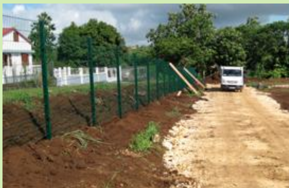
Pose d'une clôture (source : NEOEN)
