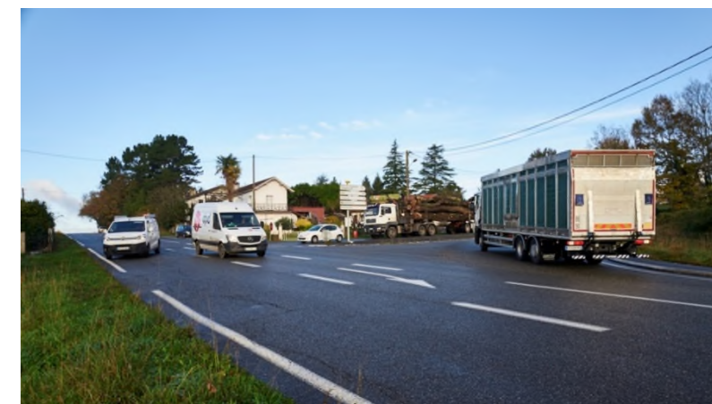
Figure 5 : Carrefour RD33/RD817 non adapté au trafic important de transit avec de nombreux poids lourds et générateur de remontées de file sur la RD33
