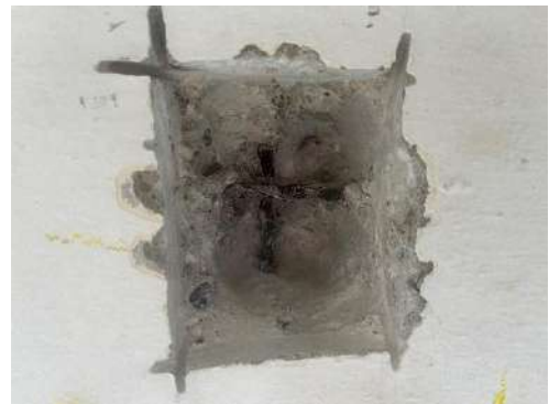
Figure 5: Sondage au burineur
