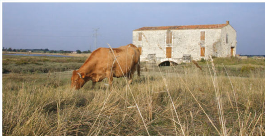
Moulin des Loges [Marais de la Seudre, 17] (coll. CREN)
